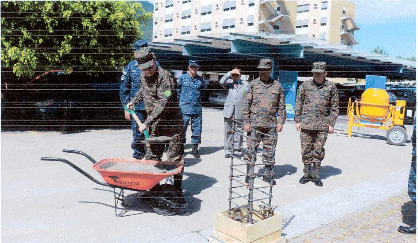
El Señor Ministro de la Defensa coloca la primera piedra del edificio del parqueo del HMC.
