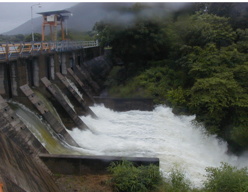
Central Hidroeléctrica Guajoyo.
