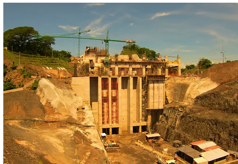
Proyecto Expansión CH 5 de Noviembre
