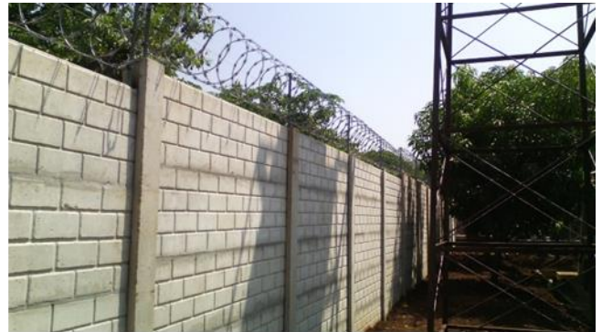
Muro perimetral de resguardo de la agencia Cara Sucia, construido
