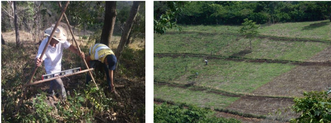
Elaboración y uso de nivel tipo "A" en San Francisco Gotera y Acequias de laderas establecidas en Jiquilisco
