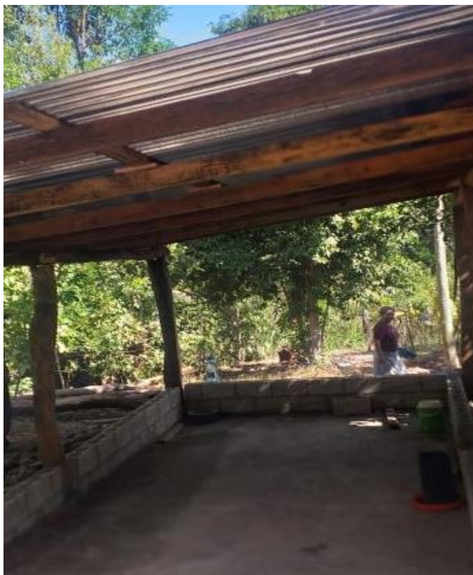
Dos vistas de construcción de galera finalizada para explotación con proyecto de gallina mejorada de doble propósito huevo y carne a desarrollar por la Sra. María Reyna Díaz Cantón La Estancia, Caserío Copante en municipio de Cacaopera, departamento de Morazán, beneficiaria atendida por extensionista destacada en agencia de extensión de CENTA , Osicala .
