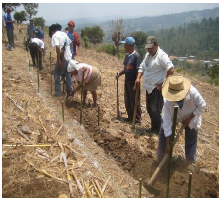
Capacitación en construcción de acequia de ladera, Chalchuapa, Sta. Ana
