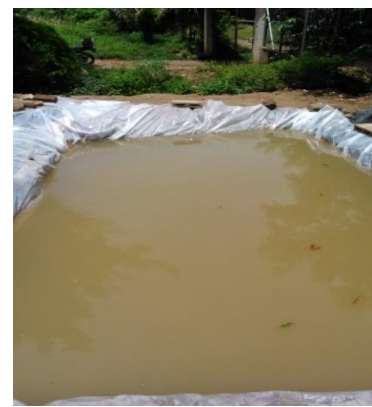
Construcción de reservorio para peces, El Paisnal
