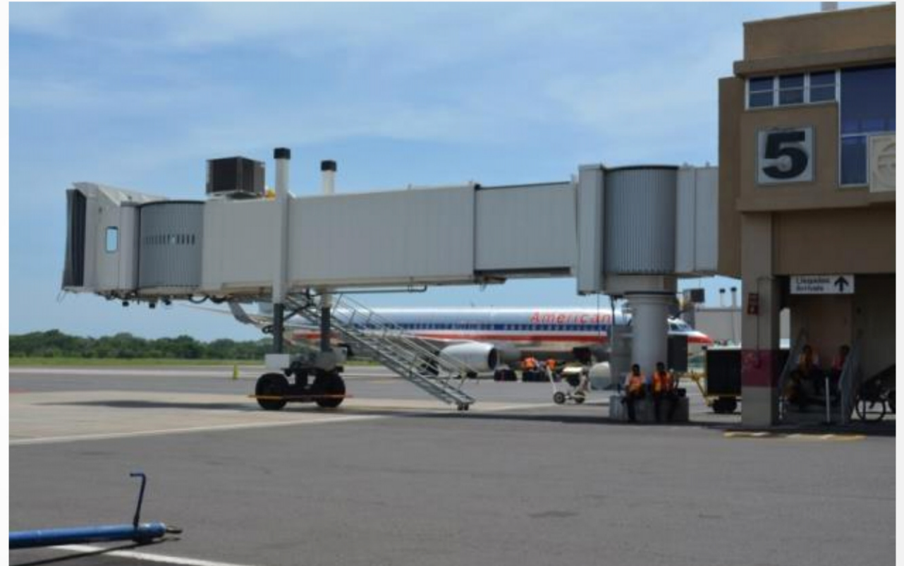
SUSTITUCIÓN DE 11 PUENTES DE ABORDAJE
