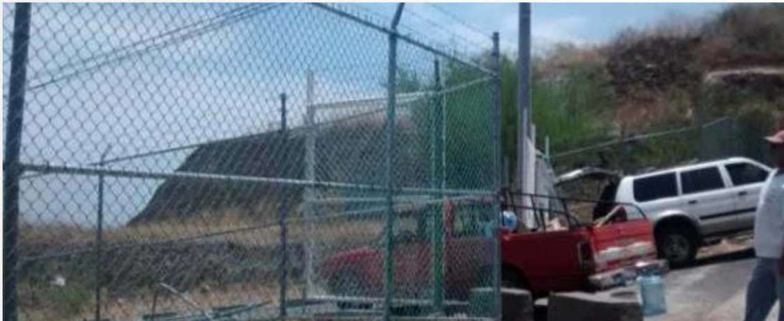
REPARACIÓN TRAMOS DE CERCO PERIMETRAL
