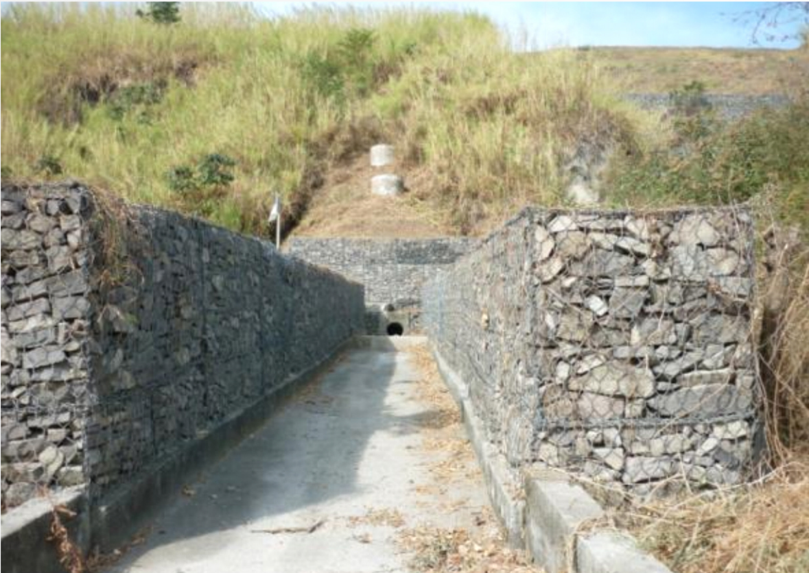
MANTENIMIENTO OBRAS RÍO ARENAL
