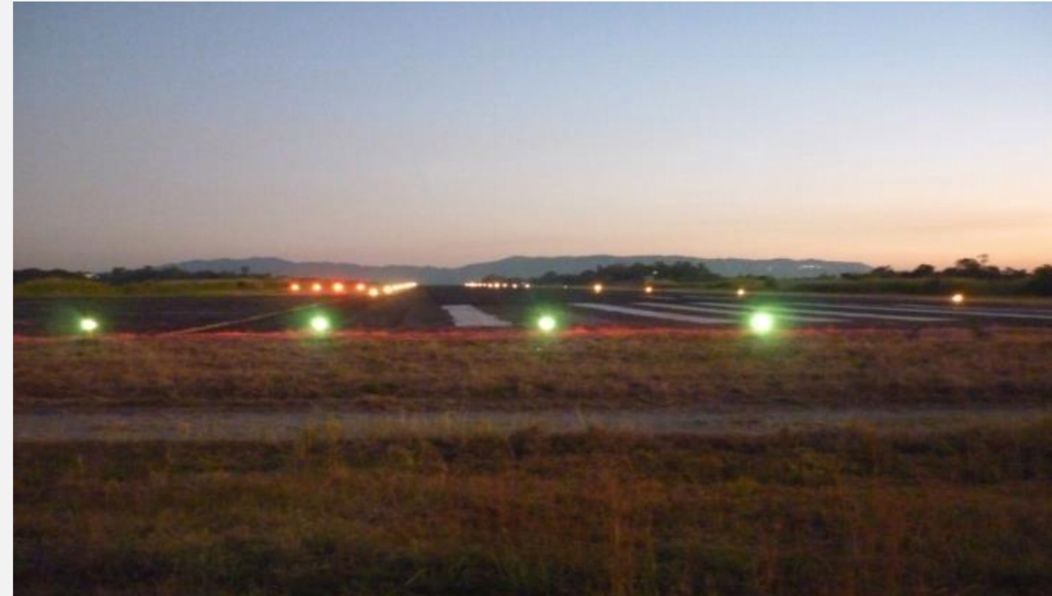
REPARACIONES SISTEMA DE LUCES
