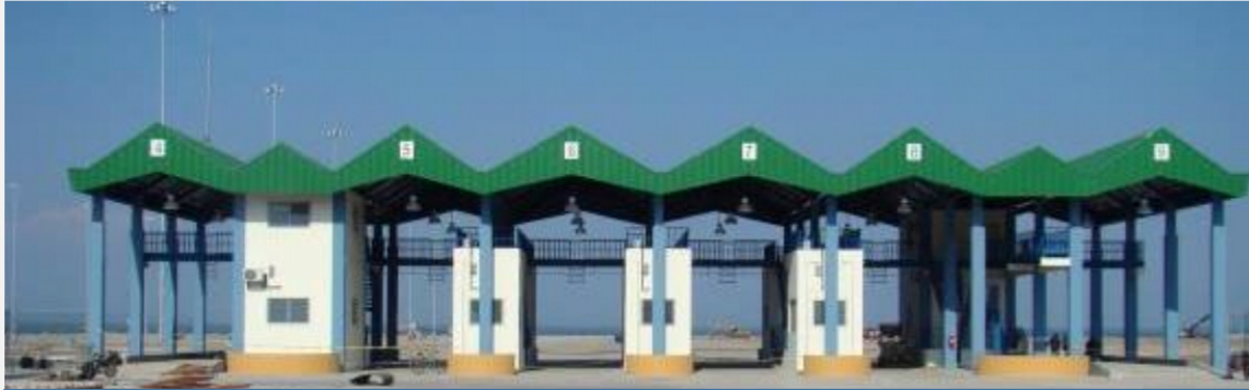
PINTURA DE 60 COLUMNAS DE TERMINALES Y SUB ESTACIÓN ELÉCTRICA
