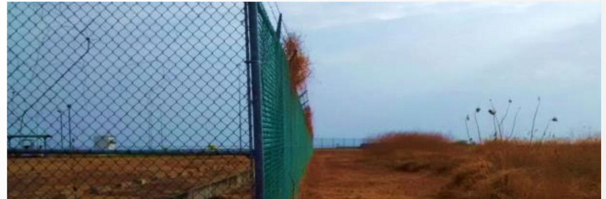
CHAPODA A AMBOS LADOS, DE 1,370 METROS DE CERCA PERIMETRAL
