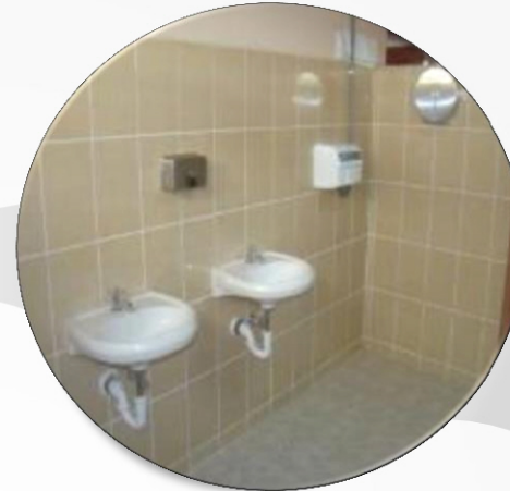
REHABILITACIÓN DE LOS SERVICIOS SANITARIOS
