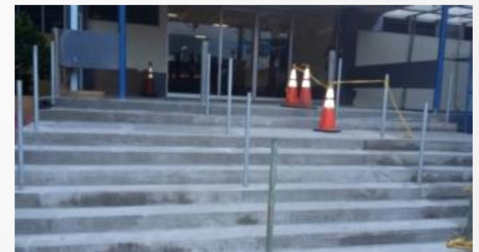
REMODELACIÓN ACCESO No. 4
