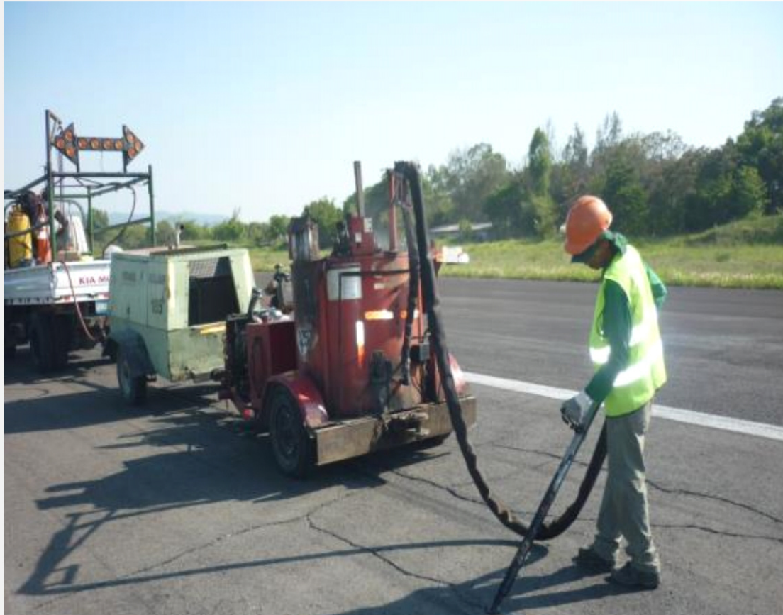
SELLADOS GRIETAS PISTA PRINCIPAL
