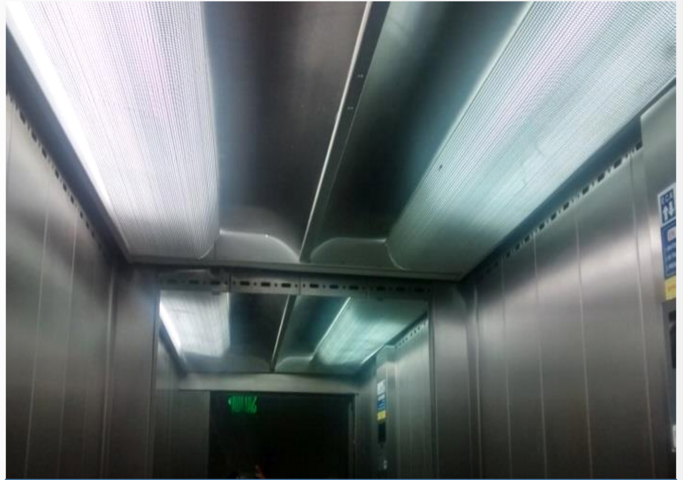
REPARACIÓN DE ELEVADOR DEL EDIFICIO ADMINISTRATIVO
