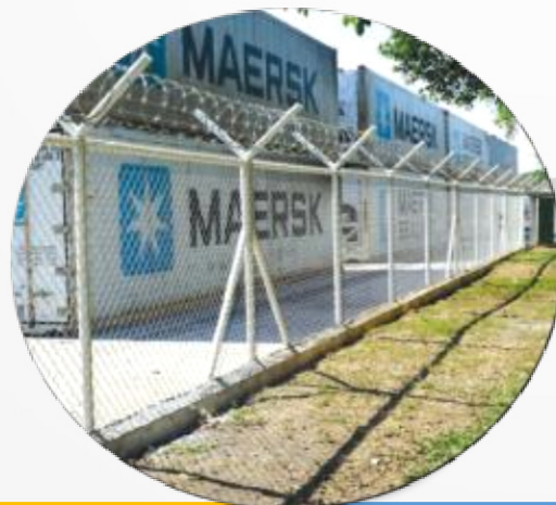
SUSTITUCIÓN DE 1,575 MT. DE CERCADO PERIMETRAL
