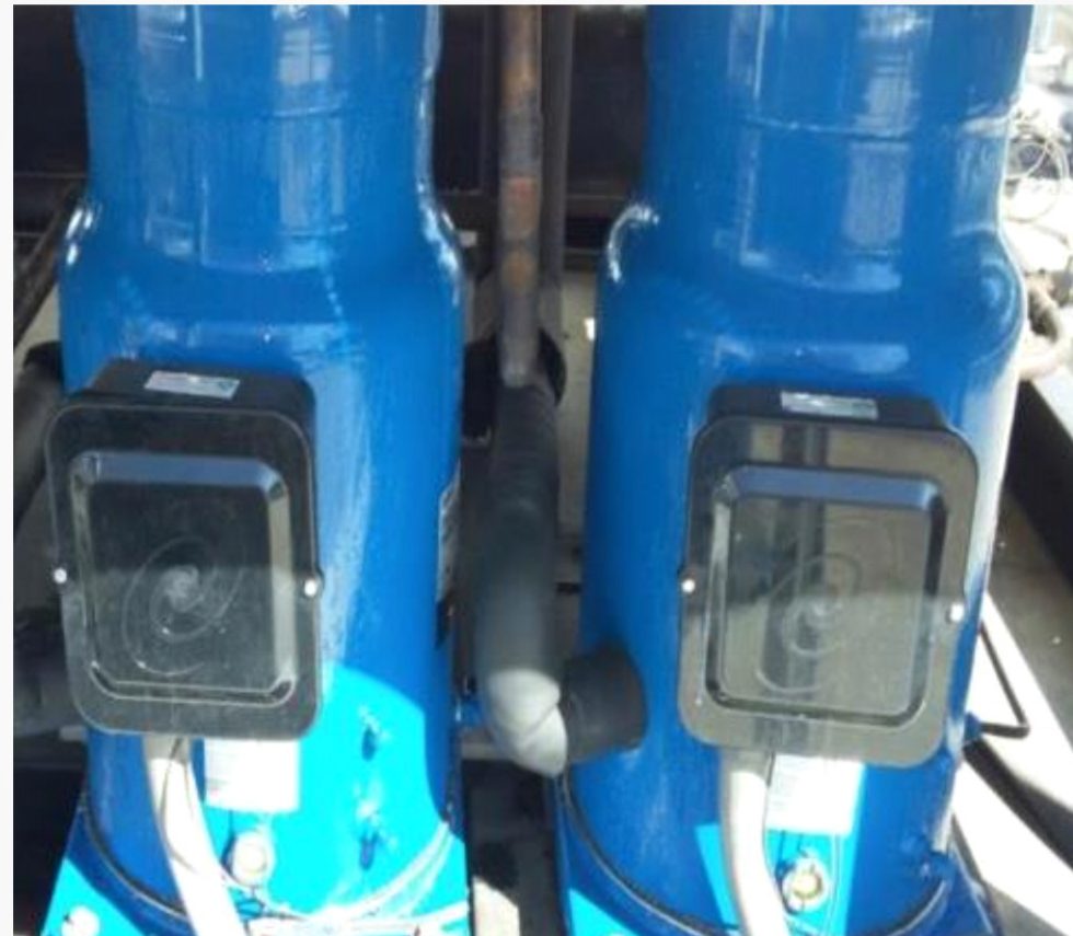
SUSTITUCIÓN DE 2 COMPRESORES DEL SISTEMA CENTRAL DE AIRE ACONDICIONADO
