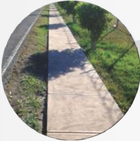
CONSTRUCCIÓN DE ACERA PEATONAL ENTRE ACCESO 5 Y 6
