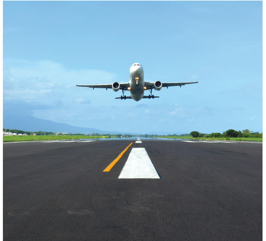
Se finalizó la rehabilitación de la pista principal, calle de rodaje y perimetrales lo que garantiza mayores niveles de seguridad operacional de la terminal aérea.
