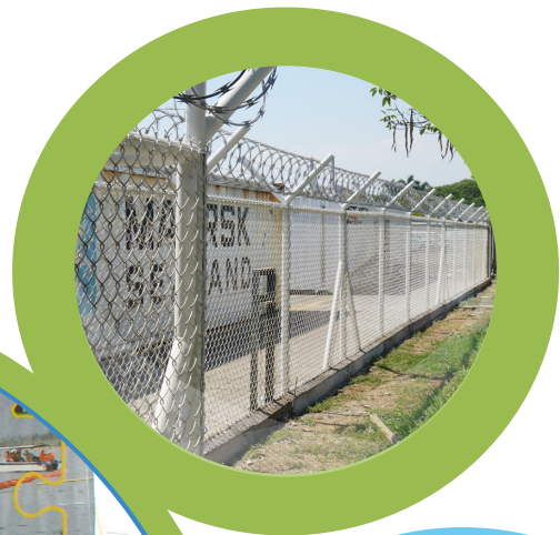
Sustitución de 1, 575 metros de cercado perimetral
