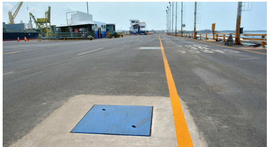
DESPUÉS. CEPA comprometida con la modernización del Puerto de Acajutla realizó la rehabilitación del pavimento asfáltico de la calle de acceso y rodaje del Muelle "A".
