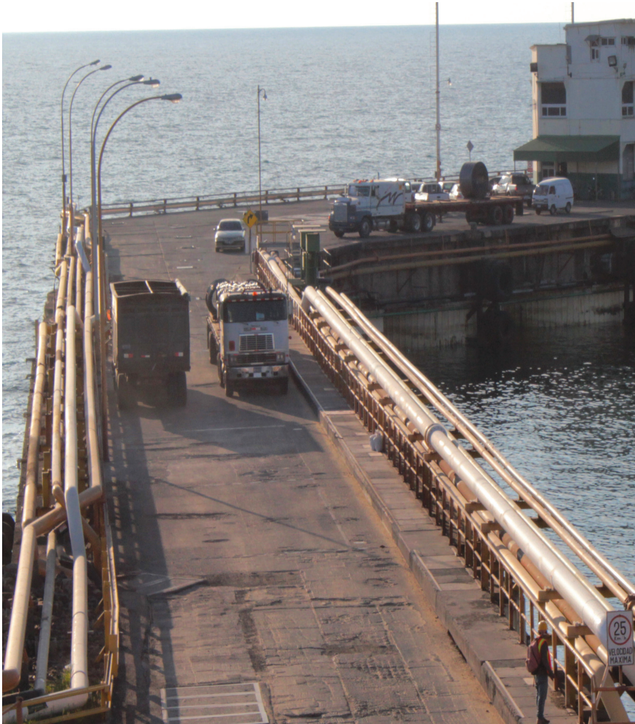
ANTES. Las condiciones que presentaba el muelle de acceso y el muelle "A" dificultaba el traslado de las mercaderías desde y hacia éstos.
