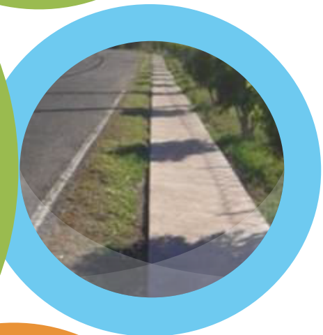
Construcción de Acera Peatonal Entre Acceso 5 y 6 del puerto
