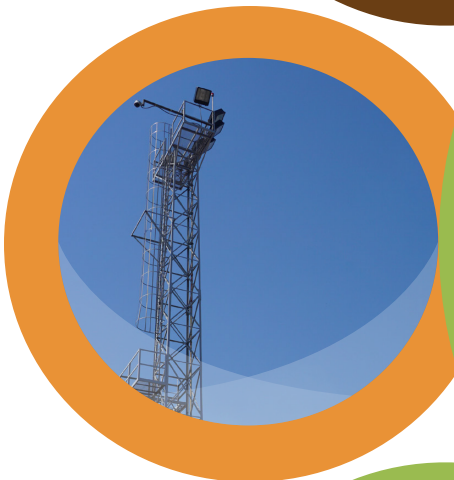
Mantenimiento de Torres de alumbrado del Patio de Contenedores
