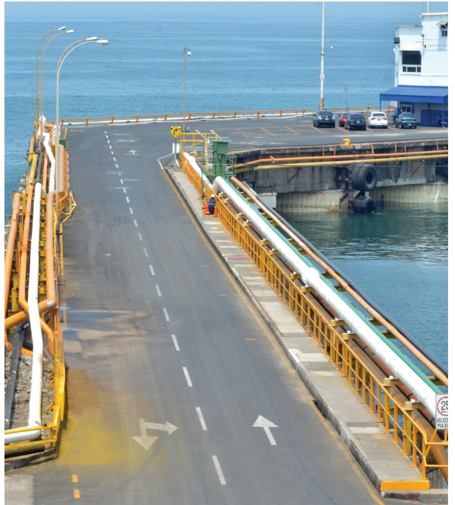
DESPUÉS. Esta obra fue ejecutada a través del convenio firmado entre la CEPA y el Programa de las Naciones Unidas para el Desarrollo (PNUD), con la supervisión de la Oficina de Servicios para Proyectos de las Naciones Unidas (UNOPS)
