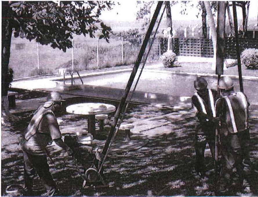
PERFORACIÓN CON ENSAYO DE PENETRACIÓN ESTÁNDAR EN LA PARTE ALTA DEL TALUD.
