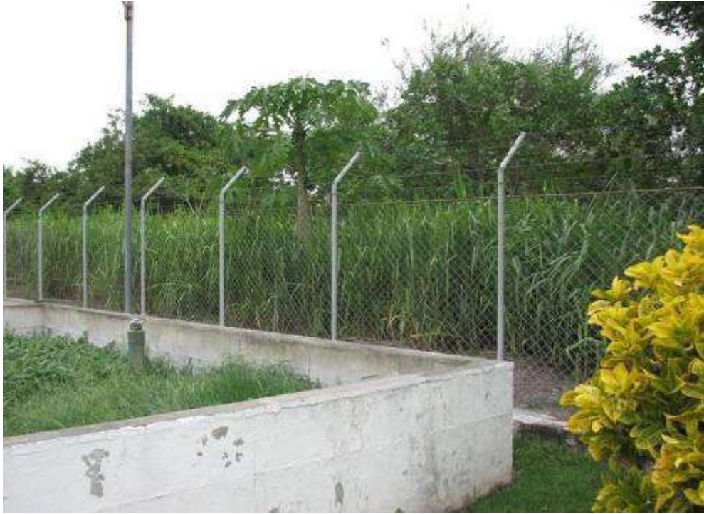
Panorámica este de los exteriores de la Planta de Tratamiento de Aguas del AIES, obsérvese el alto nivel de la vegetación gramínea y la existencia de árboles frutales (Foto: Ricardo Ibarra Portillo).
