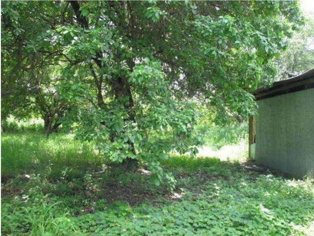
Panorámica de los exteriores de la Bodega de Activo Fijo, sector este de la Terminal de Pasajeros (Foto: Ricardo Ibarra Portillo).
