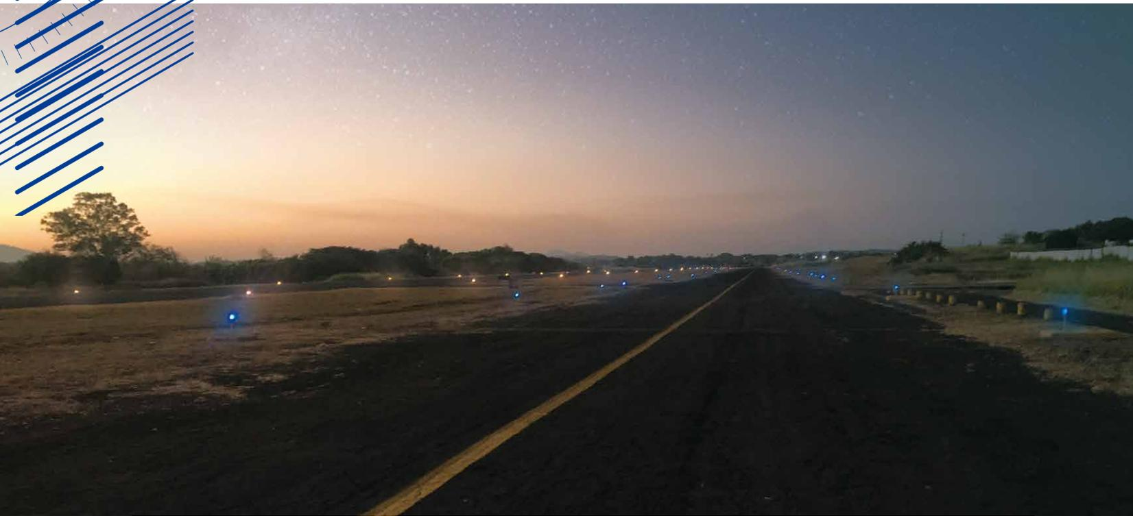
Dentro del plan de mejoramiento de señales visuales y no visuales del aeropuerto, se instalaron 40 nuevas luces de borde de calle de rodaje, lo cual incrementa de manera significativa la seguridad operacional de aeronaves que efectúen operaciones nocturnas.
