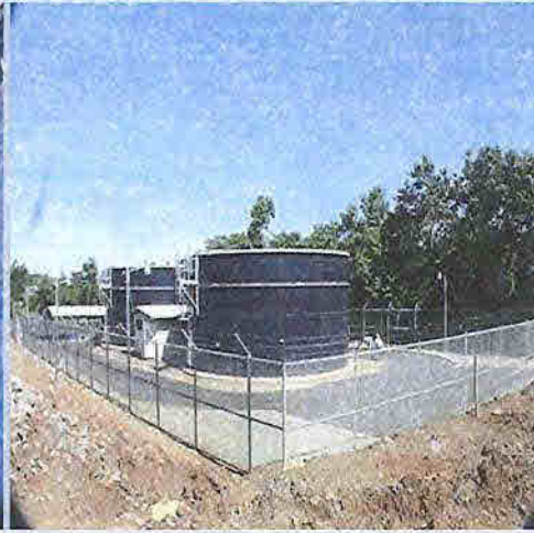
Tanques de almacenamiento o agua potable
