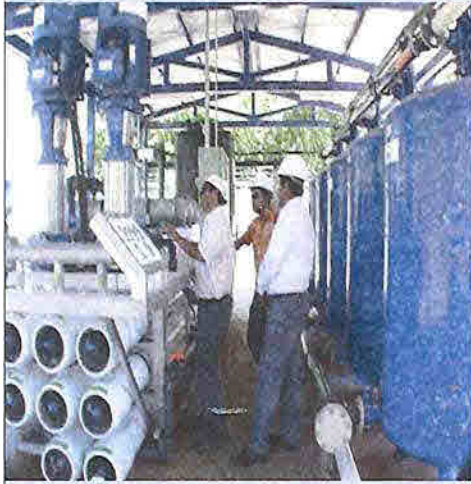
Planta de Tratamiento agua potable
