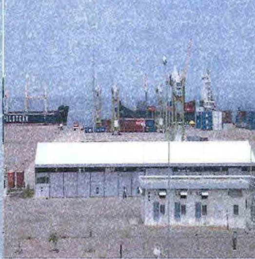
Bodega , Talleres de Mantenimiento y Subestación 1800 mts 2
