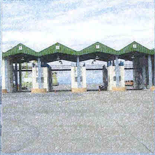
9 Puertas de Acceso y 4 Básculas
