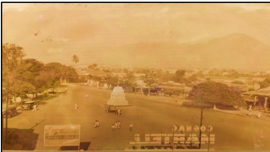
Imagen 6. Avenida Independencia 1935-1936. En sus cercanías se ubicaban las estaciones de ferrocarril de Occidente y Oriente. El mercado La Tiendona y las instalaciones de la Constancia se encuentran actualmente en los terrenos de la antigua estación del ferrocarril de Occidente. Fuente: Archivo Periférico de Fenadesal, álbum fotográfico FES
