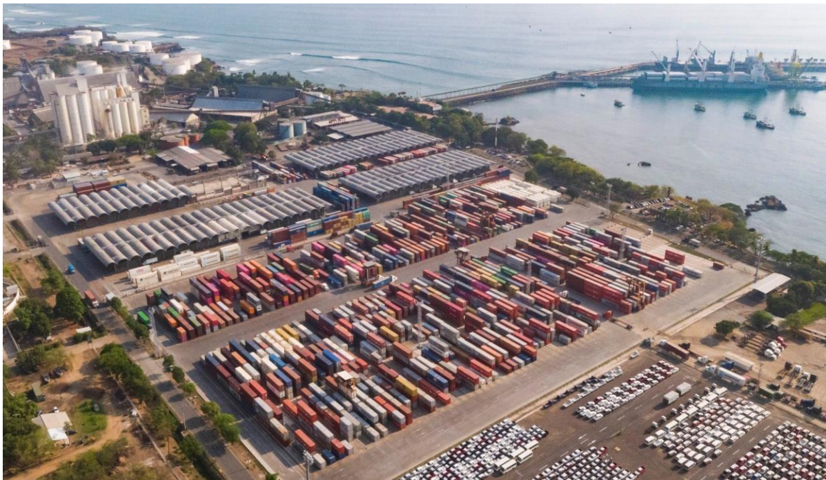
Imagen 37. Vista del patio de contenedores, año 2020
