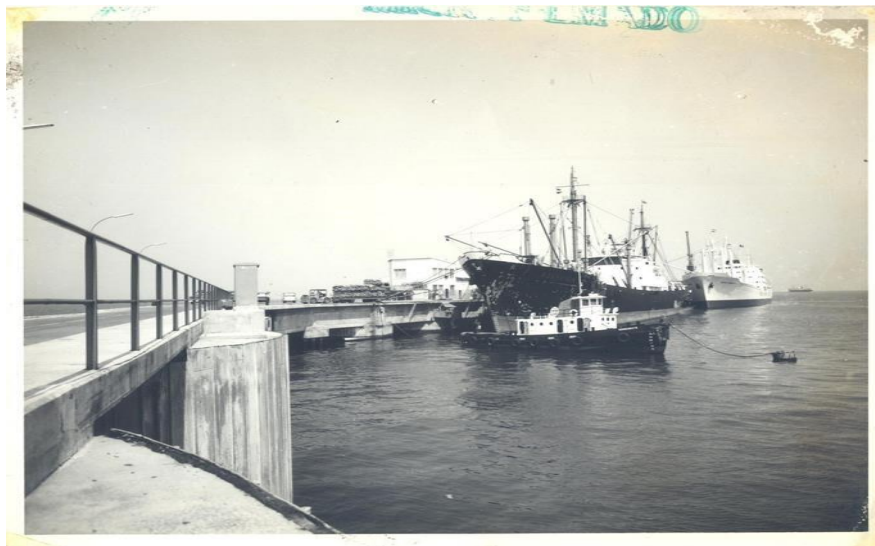
Imagen 23. Fotografía de la vista lateral del recién inaugurado Puerto de Acajutla en operaciones, se observan barcos anclados en operación de desembarque, y el remolcador Sonsonate
