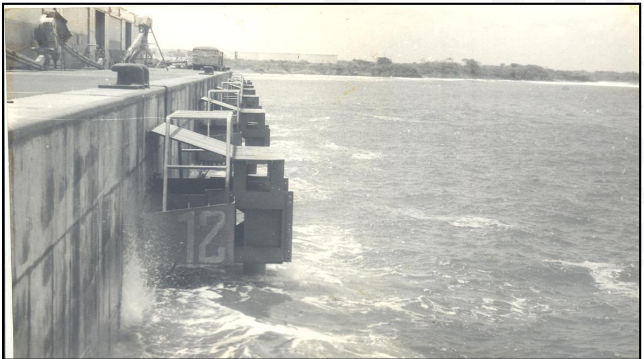
Imagen 14. Atracaderos de protección en el Puerto de Acajutla
