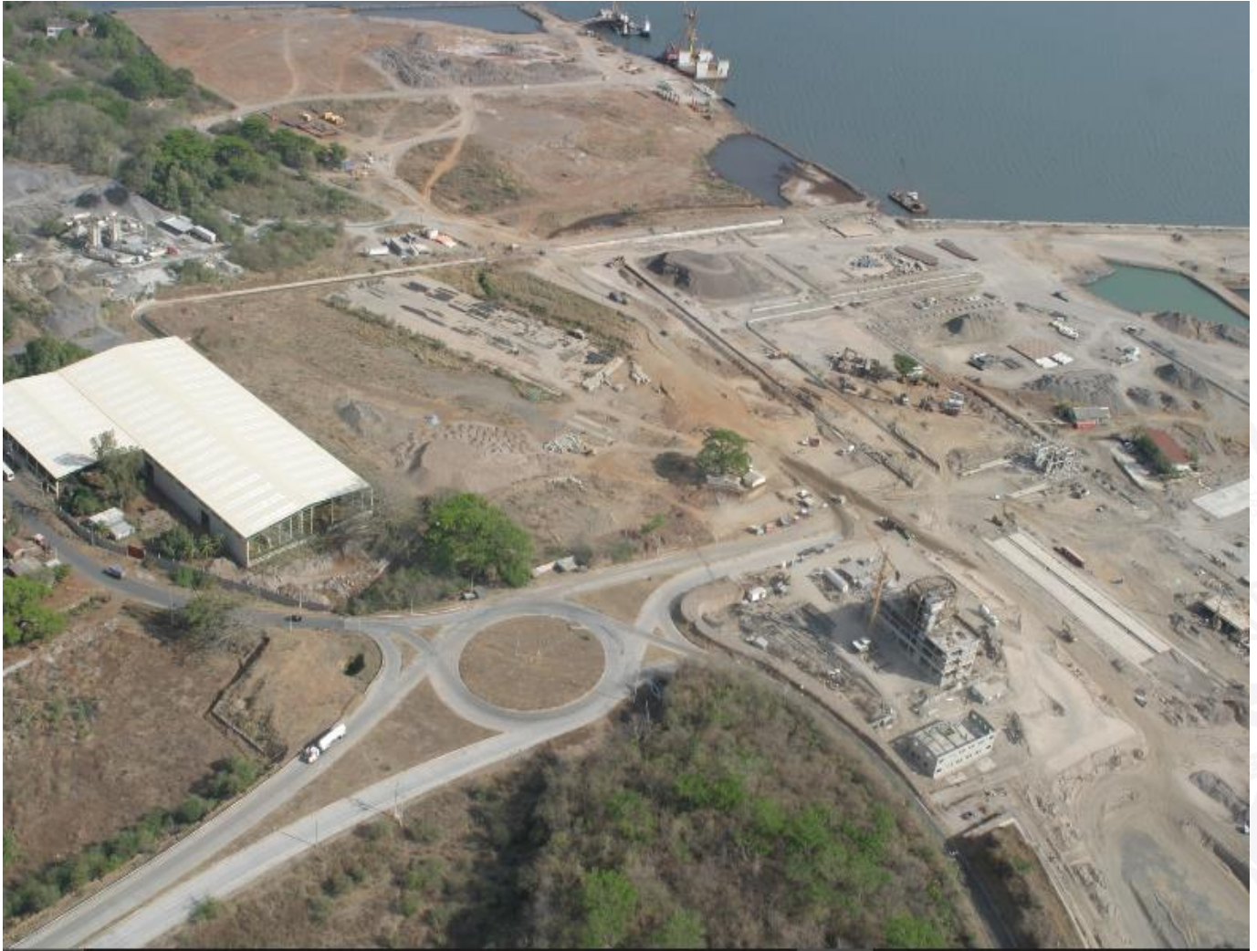
Imagen 28: Vista de la construcción del edificio administrativo, que se determinó en una superficie adecuada para acomodar a 92 personas con una superficie de 2.540 m 2 el edificio se construyó considerando la carga sísmica, por encontrarse en zona sísmica I. 39
