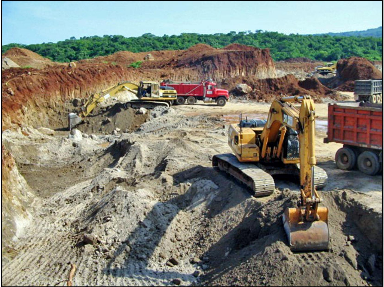
Imagen 23: Se avanza en el corte de la montaña la cual ha sido dividida en 5 etapas: excavación del material, descapote del suelo orgánico, remoción y desalojo de madera. El material de la montaña será usado para rellenar áreas de botadero A Y B y del área de reclamación del Puerto, octubre de 2005 34
