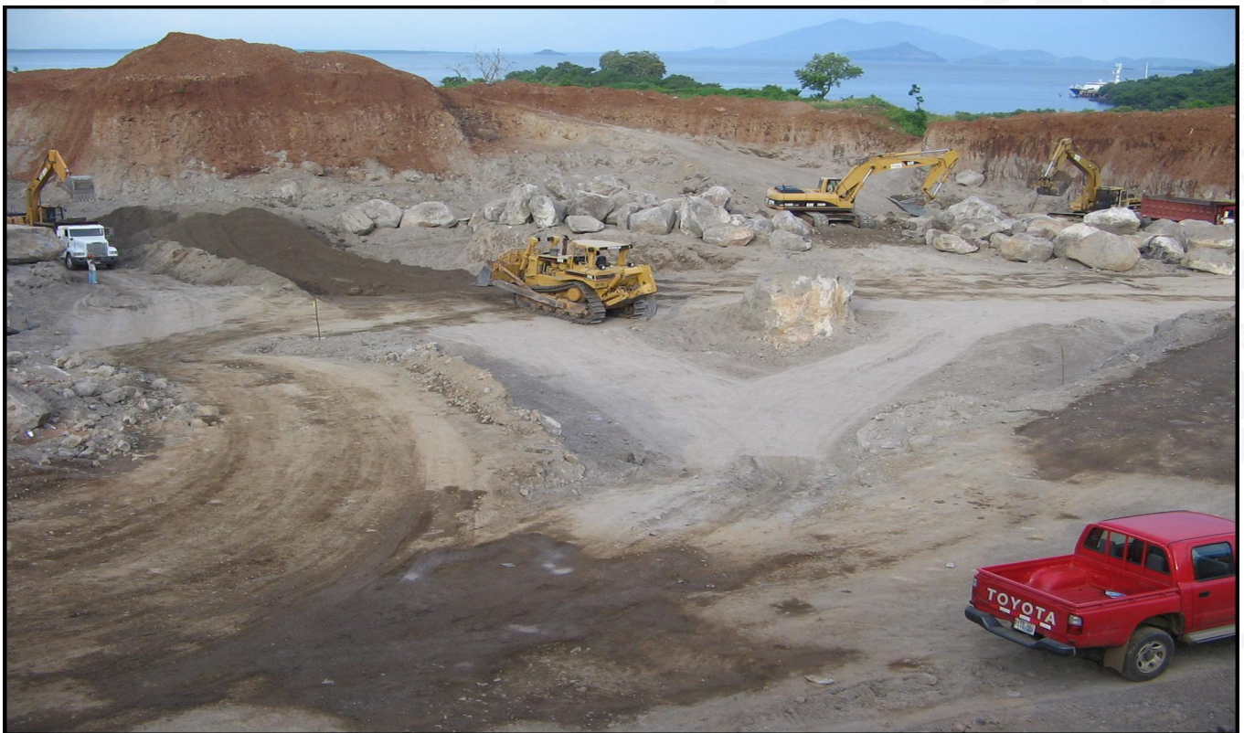
Imagen 19: Inicia los trabajos de corte de la montaña en área de atrás de las terminales portuarias proyectadas; este material de la montaña será usado para rellenar las áreas de botadero y el área de reclamación del Puerto, abril de 2006 30
