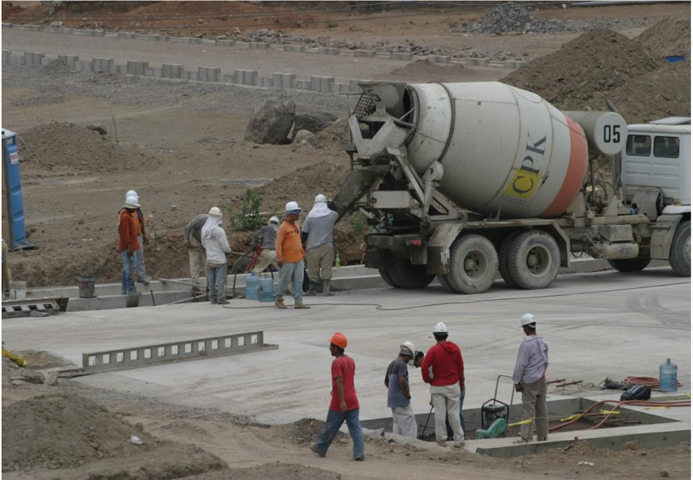
Imagen 30: Personal del contratista realizando colado de losa del Puente de carga 41
