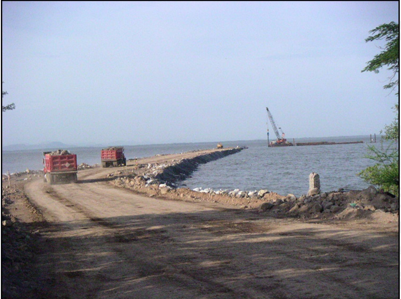
Imagen 21: Inician los trabajos de construcción del muelle temporal que mide 160 metros de tablestacado y servirá para el anclaje de los diques flotantes en forma paralela a lo largo de la línea del enrocado temporal, abril de 2006 32
