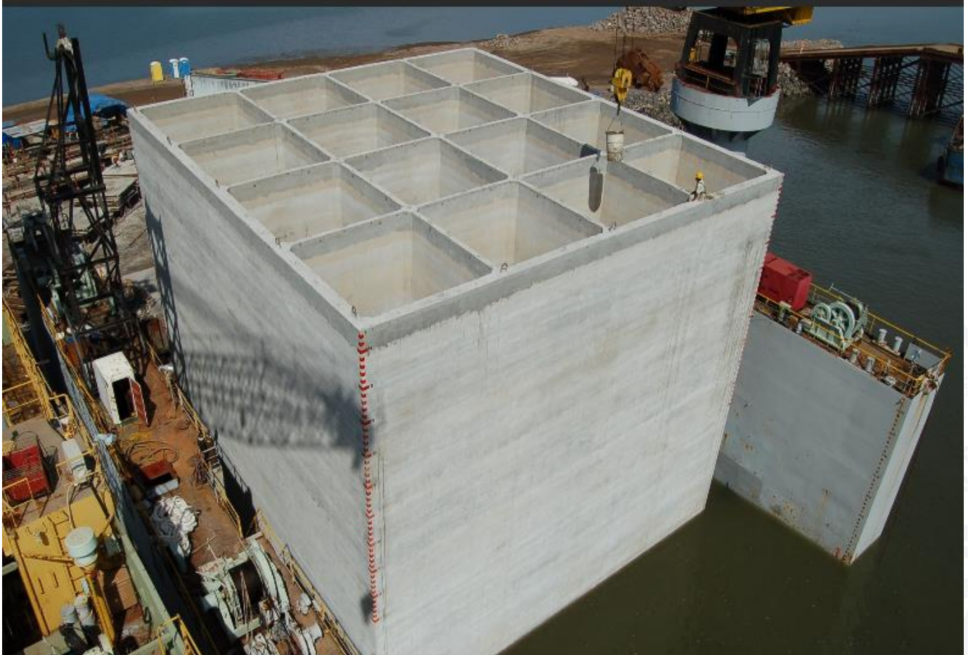
Imagen 26: Vista de los cajones de concreto armado, que al ser terminados serán colocados para formar la terminal multipropósito y la terminal de pasajeros, cada cajón tiene un peso de 2,700 toneladas y 20 metros por cada lado 37
