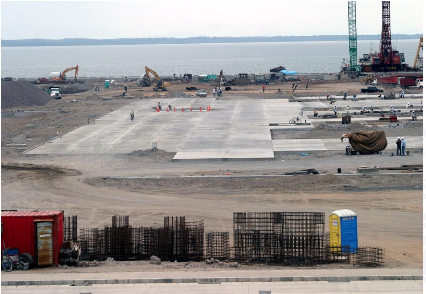
Imagen 29: Colocando la capa de pavimento, en el área de construcción del muelle, con un avance de 27,080 m 2 de un total de 104,886.00 m 2 , mayo 2008 40
