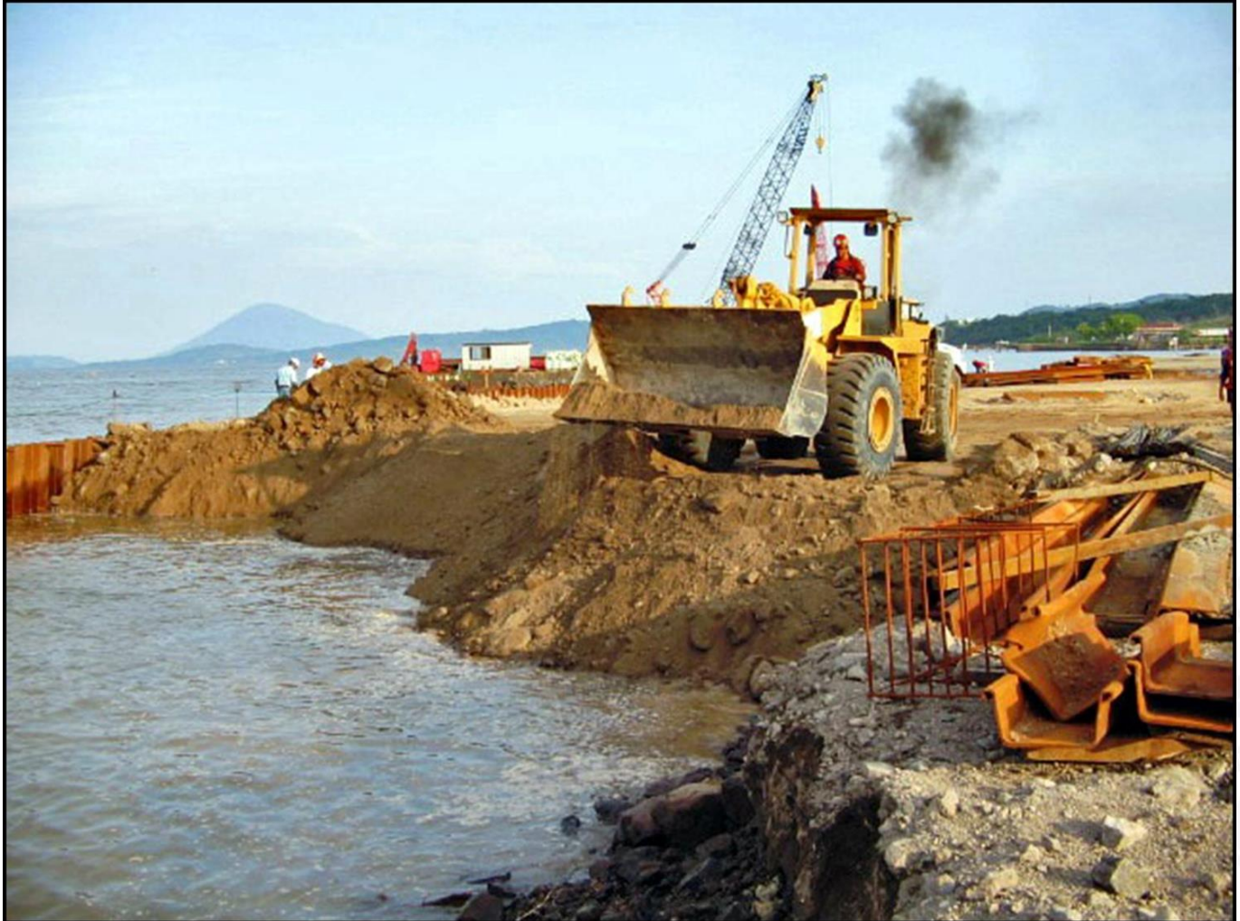
Imagen 24: Se inicia el trabajo de relleno en el área de reclamación del puerto, en la cual se determina el material apropiado para cada área, mediante la realización de un análisis granulométrico al suelo, julio de 2005 35
