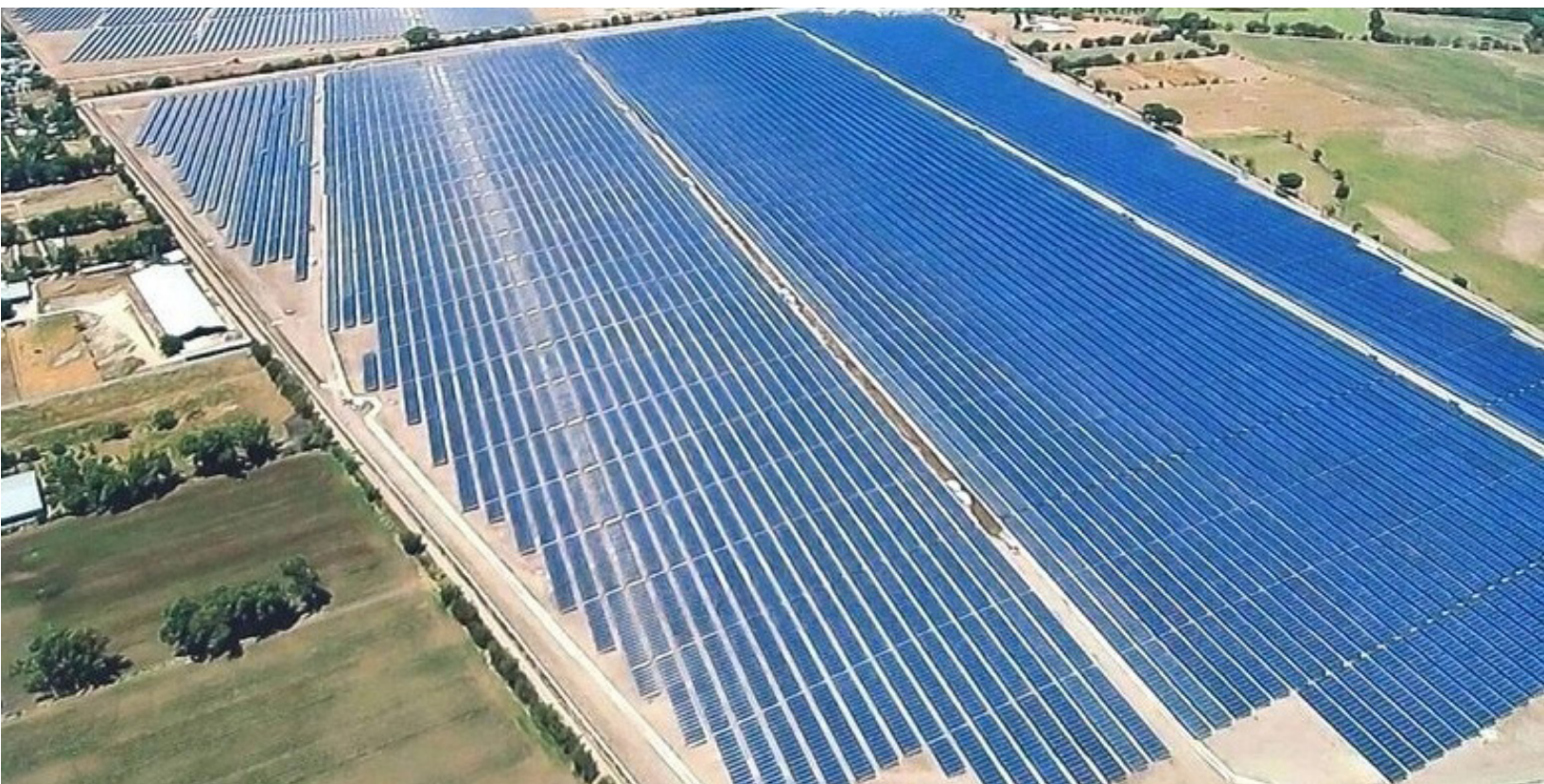
Figura No.5. Planta fotovoltaica Providencia Solar de la empresa NEOEN inaugurada en 2017 como parte del proceso de licitación por 170 megavatios de energía lanzada en 2016.
