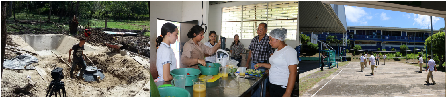
Figura No.15. Inicio de la construcción del biodigestor que producirá combustible para la cocción de alimentos en el Instituto Nacional Dr. Francisco Martínez Suárez.
