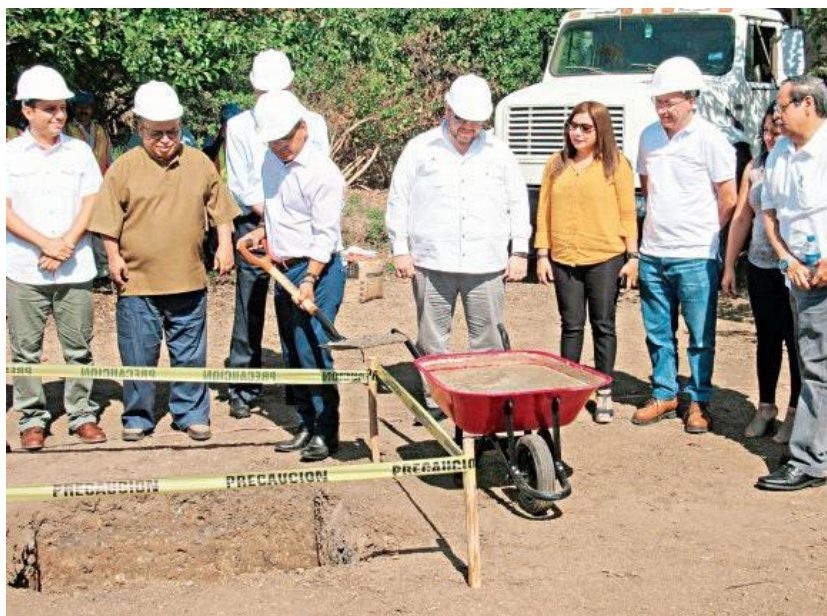
Figura No. 8. Vicepresidente Oscar Ortiz coloca primera palada de concreto para construcción de Primera planta de Gas Natural
