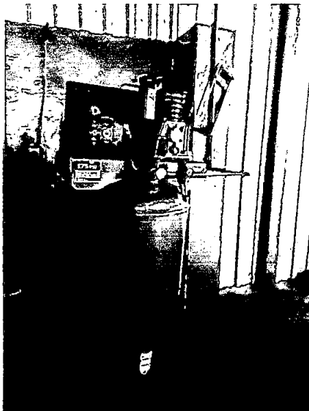
COMPRESOR Y SISTEMA DE DISTRIBUCION DE AIRE COMPRIMIDO
