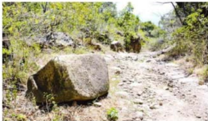
Los trabajos de mejoramiento en dicha arteria se han frenado por que se declaró desierta la licitación.
