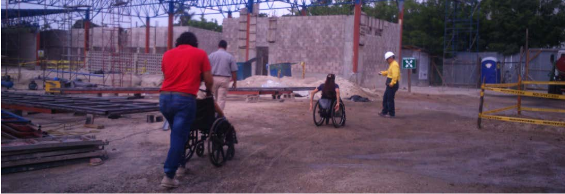
Proyecto de construcción de la terminal del Sistema de Transporte Metropolitano de San Salvador, SITRAMSS
