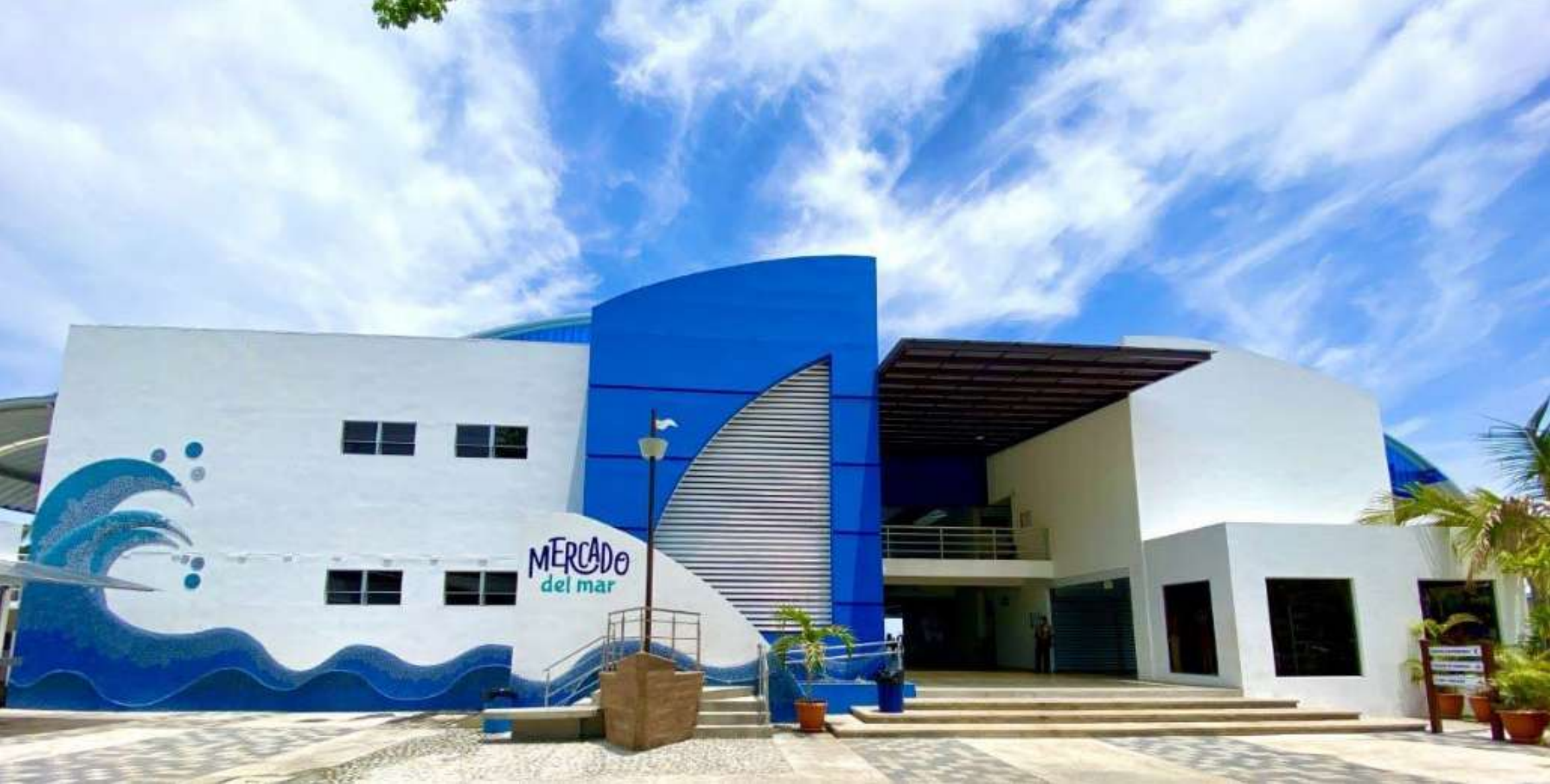
Fotografía 2: Vista general del Mercado del Mar
