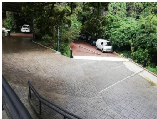
Fotografía 2. Calles internas del HMCV y Porche
