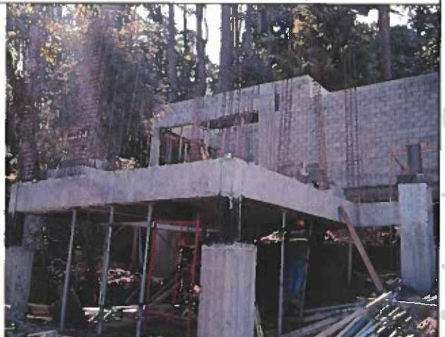
Fotografía No.6 - Zona de servicio y mantenimiento.
