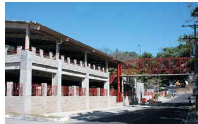
Estacionamiento con capacidad para 214 vehículos livianos en sus dos niveles, el edificio cuenta con seguridad.
