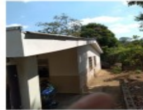
Remodelacion infraestructura en San Pedro Puxtla
