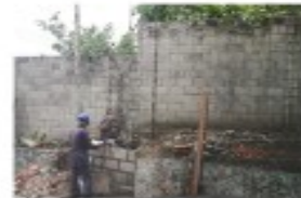
Caseta de Vigilantes en Sede Regional
