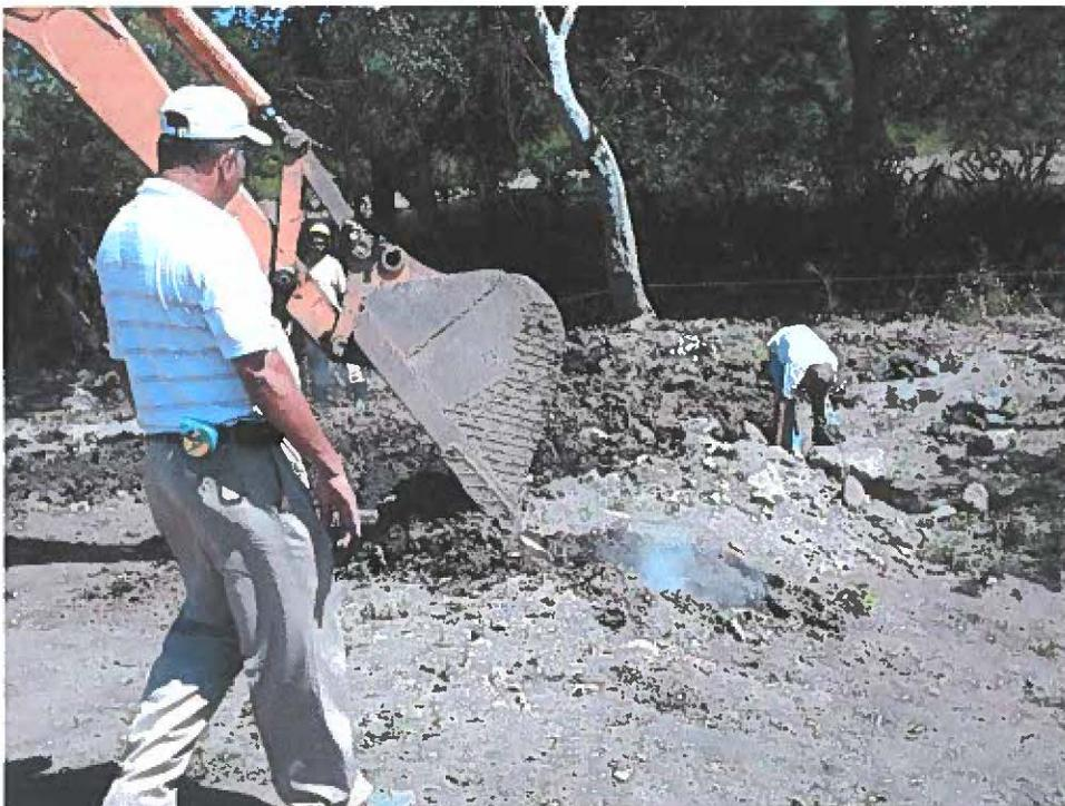
**DETALLE DE RETROEXCAVADORA RETIRANDO CAPA DE 20CM**
