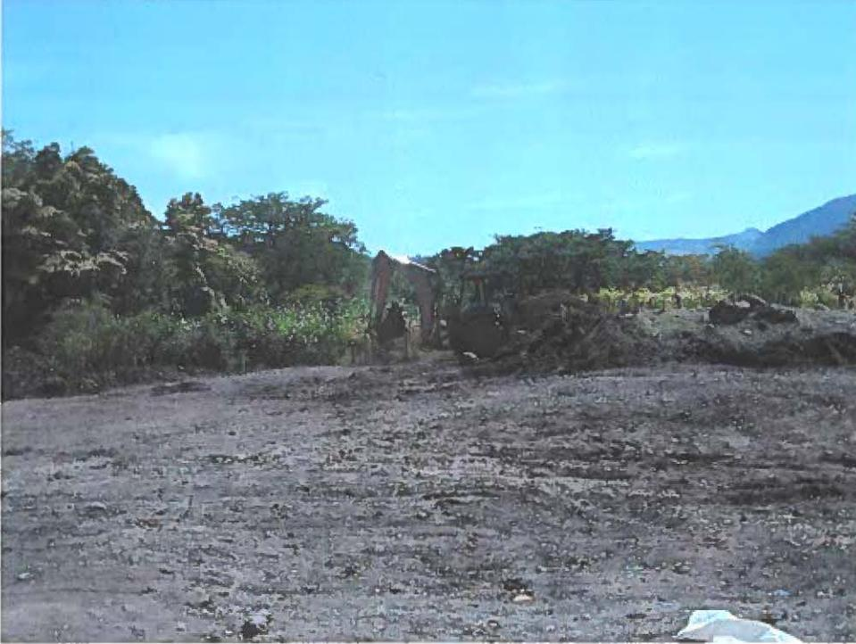
**DETALLE DE RETROEXCAVADORA RETIRANDO CAPA DE 20CM**
