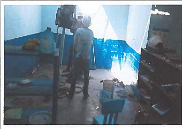
Foto 1. Perforación de sondeo N° 1
