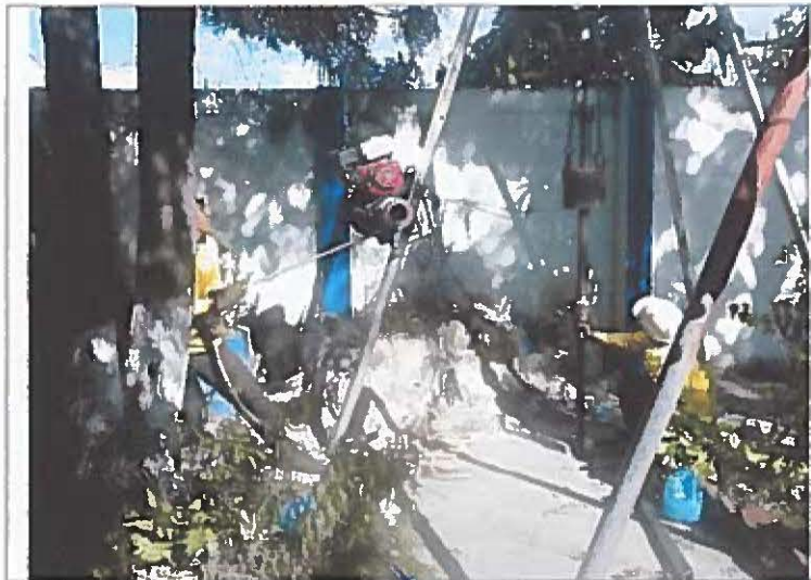
Foto 3. Perforación de sondeo N° 3
