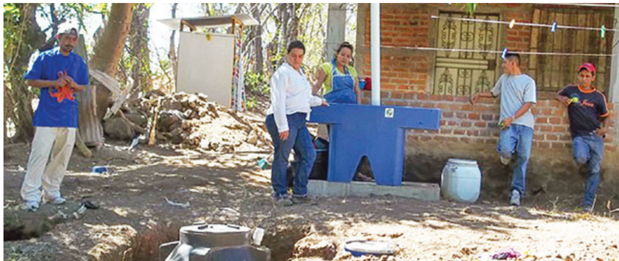
Sistema en proceso de instalación
