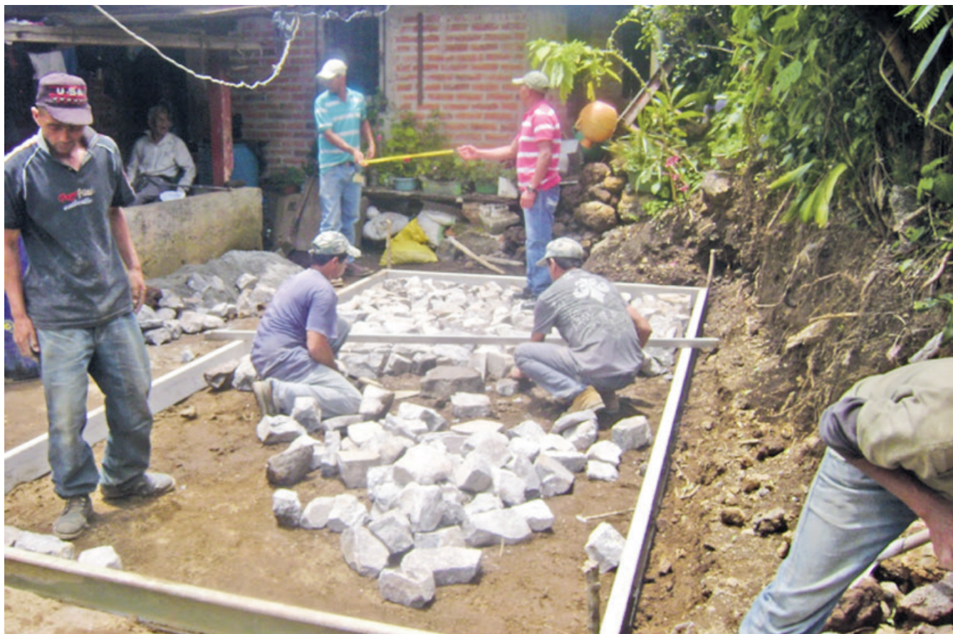
Preparación del llenado de la losa para las cisterna en el Cantón Potrerillos del Matanzas, Santa Ana.
