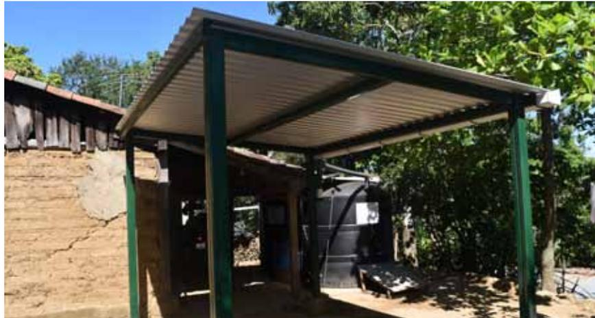
Sistema de captación de agua lluvia instalado en Chinameca, Cantón El Copinol, con fondos de Compensaciones Ambientales.
