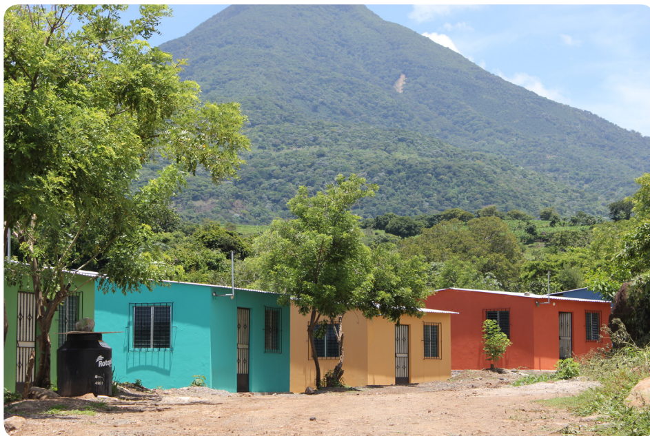
Viviendas contruidas en Proyecto Dos Quebradas, San Vicente.
