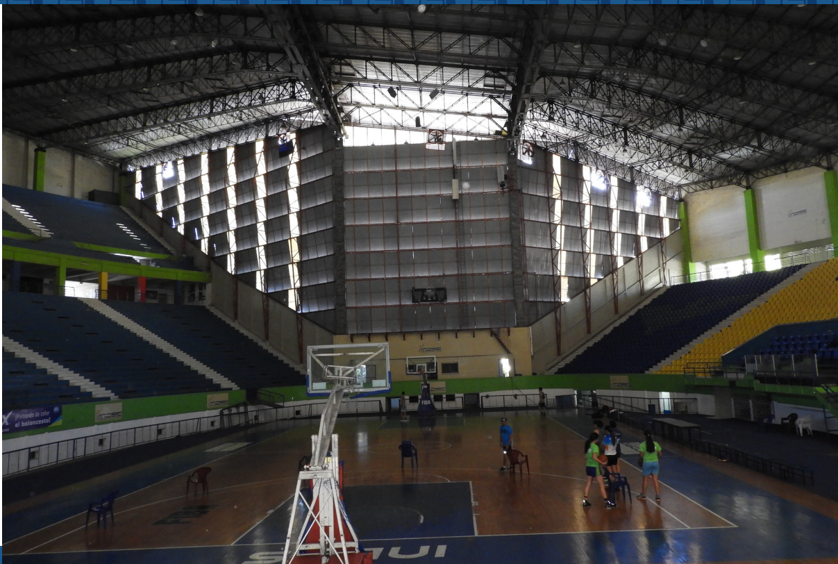
Visita de campo Diseño Final de proyecto 7318 "Mejoramiento del Gimnasio Nacional José Adolfo Pineda, departamento de San Salvador".
