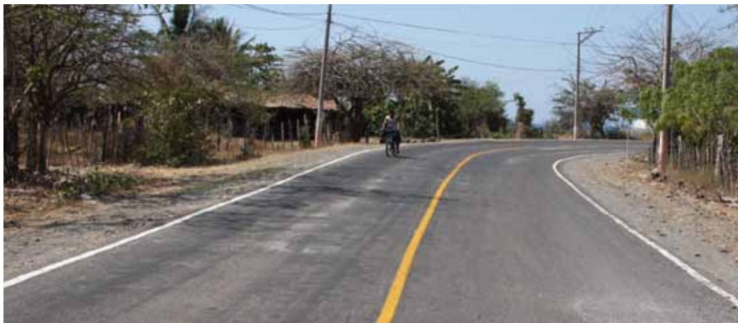
Rescate de Vía Carretera Litoral, Cantón El Jagüey
