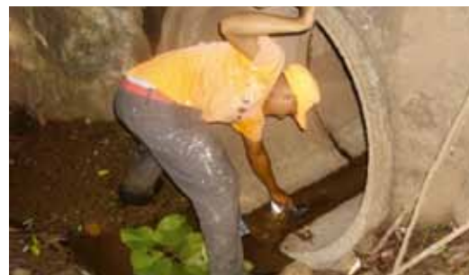
Limpieza de obras de drenaje menor
