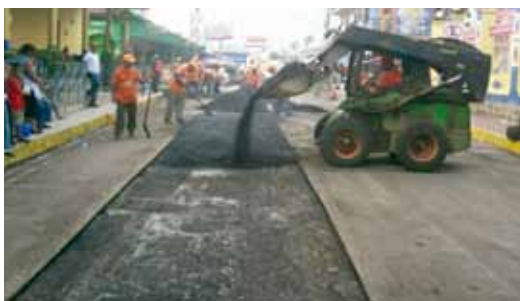
Colocación de Mezcla Asfáltica para Bacheo
