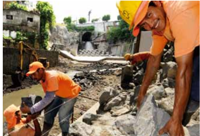
Bóveda sobre la 49 Av. Sur
