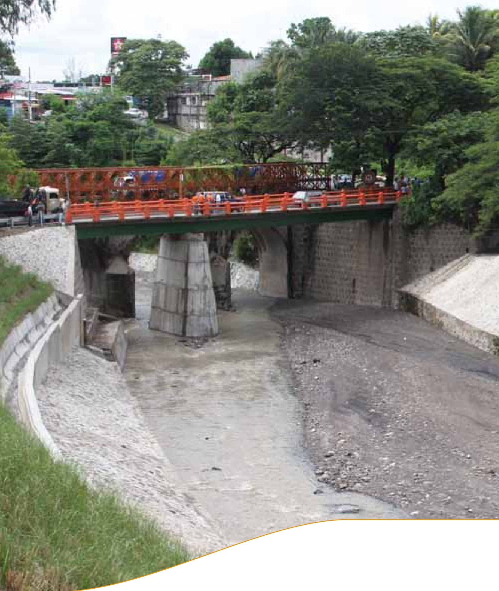
Obras de Protección a gran escala en San Vicente del Río Acahuapa
