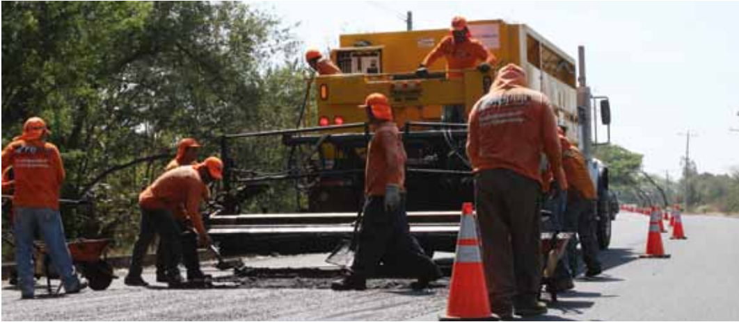
Colocación de mezcla asfáltica Carretera Litoral - Zacatecoluca
