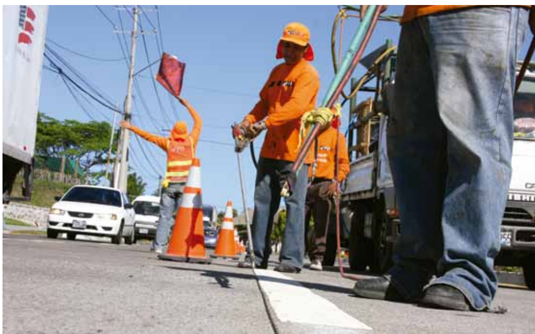
Programa de sello de grietas y fisuras
