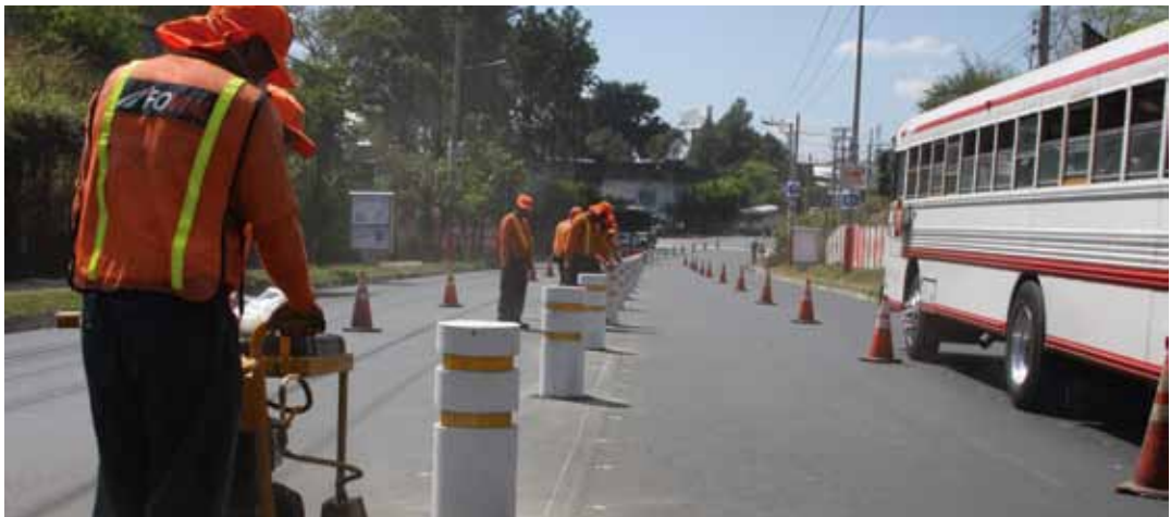
Colocación de bolaros Bulevar San Bartolo
