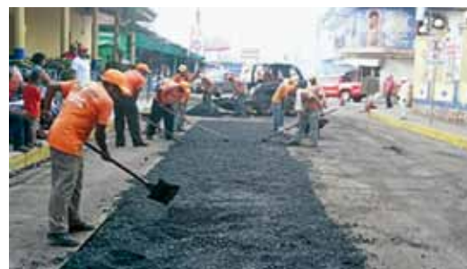
Colocación de Mezcla Asfáltica para Bacheo
