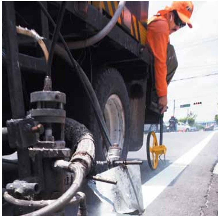
Trabajos de señalización y seguridad vial, carretera Panamericana.
