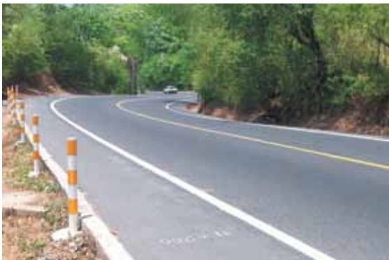
Señalización horizontal y vertical, carretera Panamericana, Estanzuelas, en la zona occidental.
