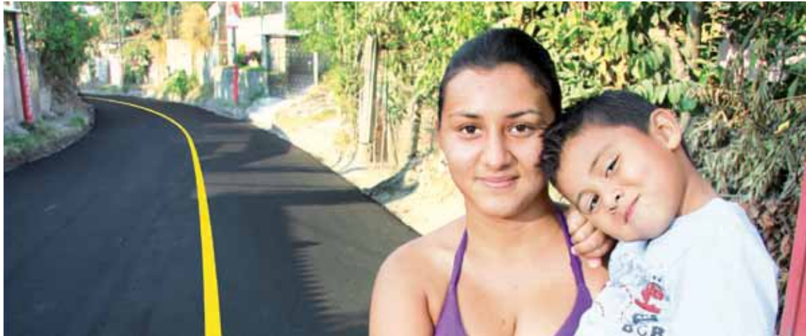
Trabajos realizados utilizando material fresado de carpeta asfáltica.
