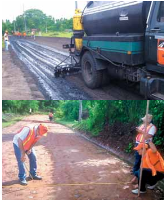
Construcción de tramos de prueba y seguimiento a su desempeño.
