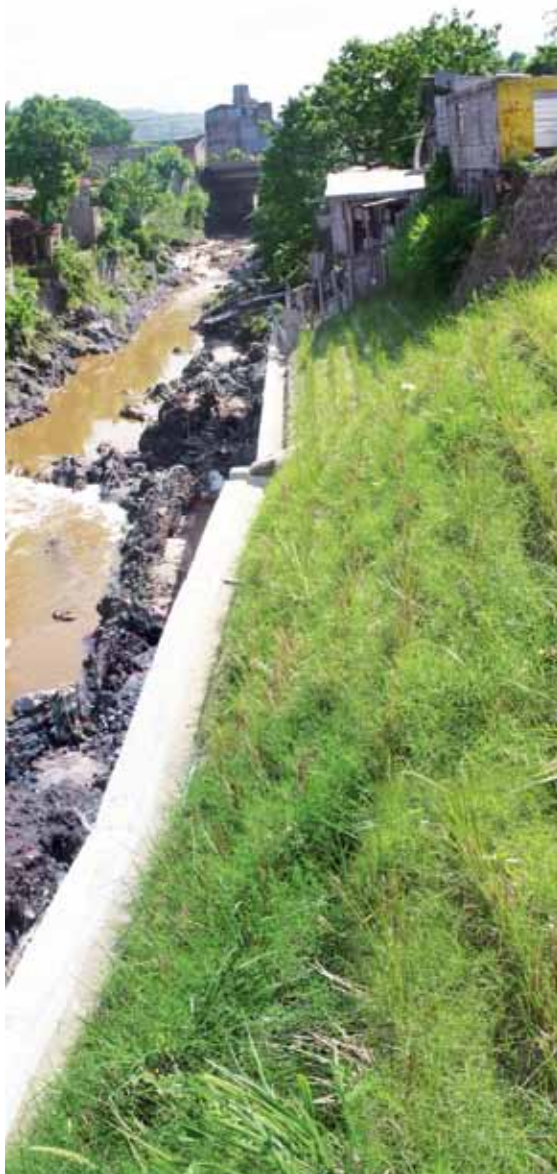
Obra de protección bulvar Venezuela.
