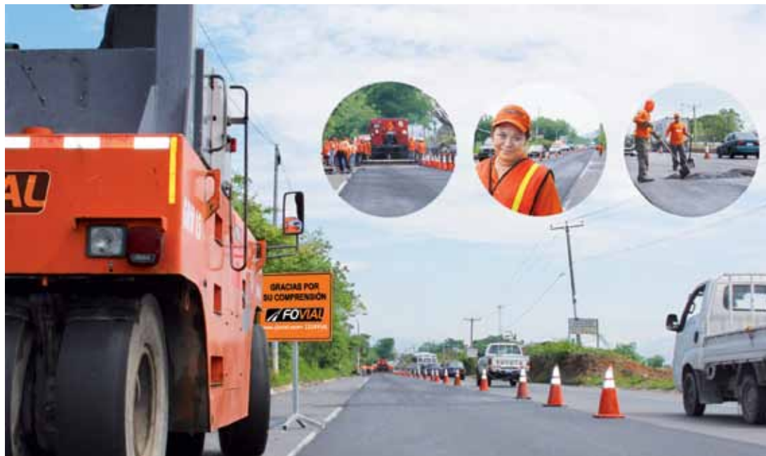
Colocación de micropavimento en la Troncal del Norte. Tramo Apopa-Quitasol.
