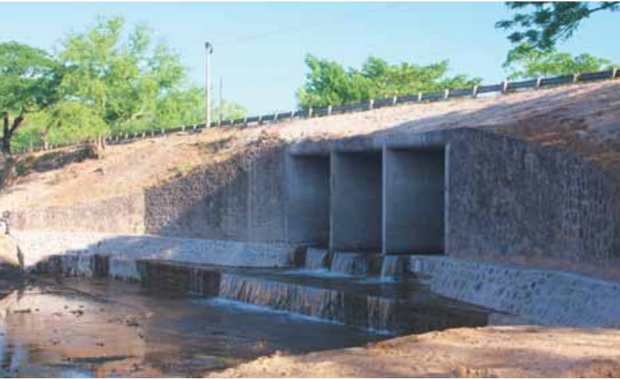
Reparación de bóveda sobre Carretera El Litoral, La Libertad.
