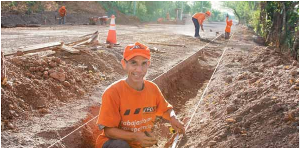
Construcción de cunetas en obras de pavimentación en Cantón El Embarcadero, El Tamarindo, La Unión.
