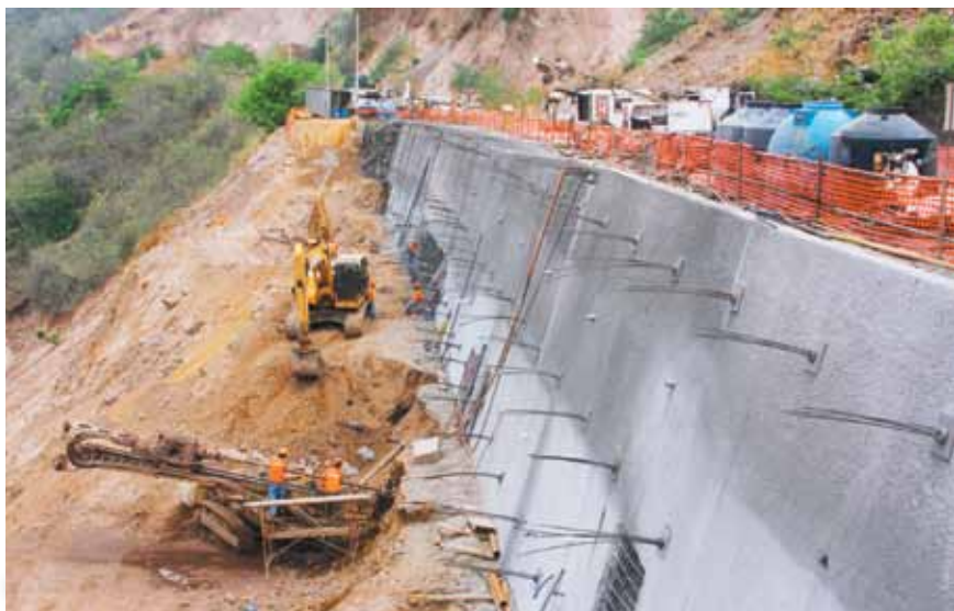
Colocación de anclajes activos, en frontera las Chinamas.
