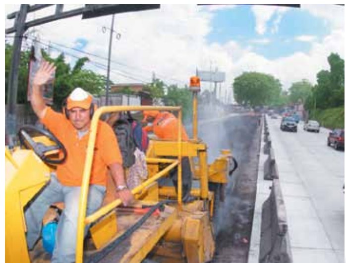
Construcción de autopista Los Chorros.
