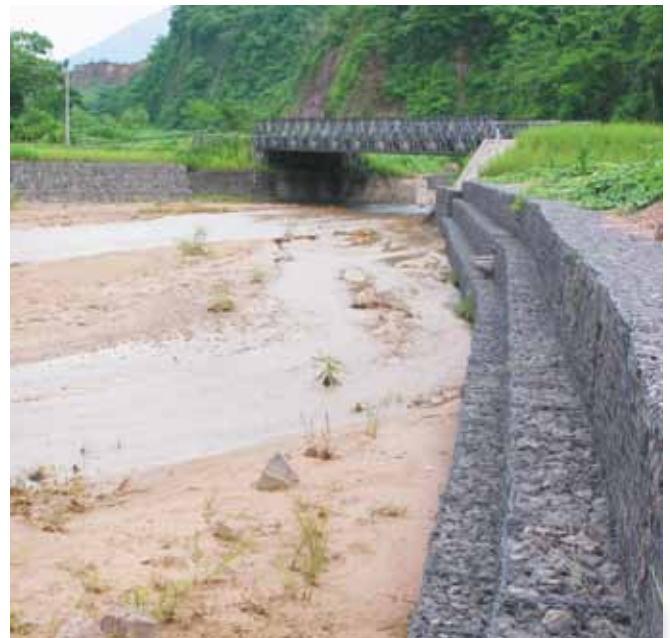
Obras de Protección en puente El Desagüe, carretera Panorámica, Candelaria, Cuscatlán.
