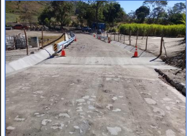
Recuperación de rodaje de vía no pavimentada, finalizada.
