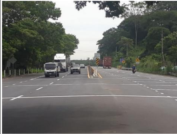
Proyecto finalizado sector de Dv. Tres ceibas
