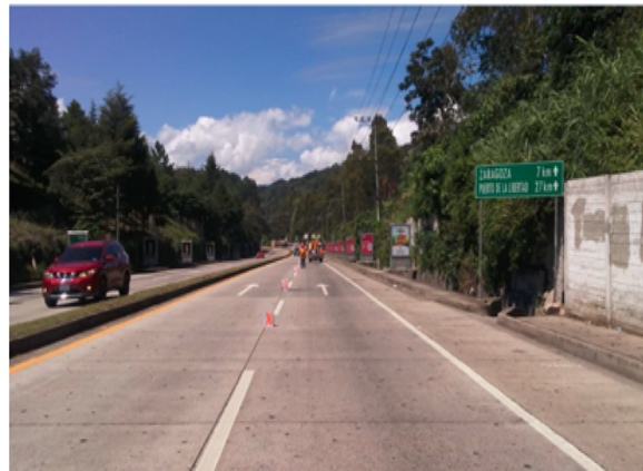
FOTO 2: Señalización horizontal en carretera al Puerto de La Libertad.
