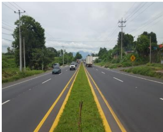
Proyecto finalizado, sector puente Colón
