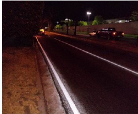
FOTO 2 EJE 47 BOULEVARD SANTA ELENA.
