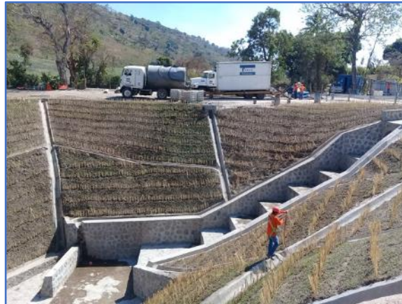
Conformación de taludes y canaletas finalizadas
