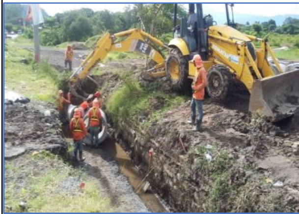
Tubería de drenaje longitudinal. En proceso de ejecución
