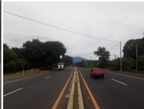
Proyecto finalizado, Sector Puente Copapayo.
