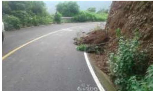
Estación 6+200, se observó material sobre cuneta de concreto hidráulico
