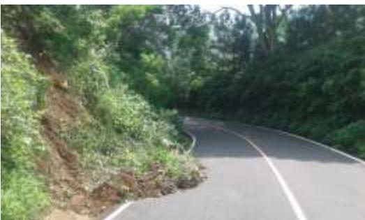
Estación 7+400, se observó material sobre cuneta de concreto hidráulico
