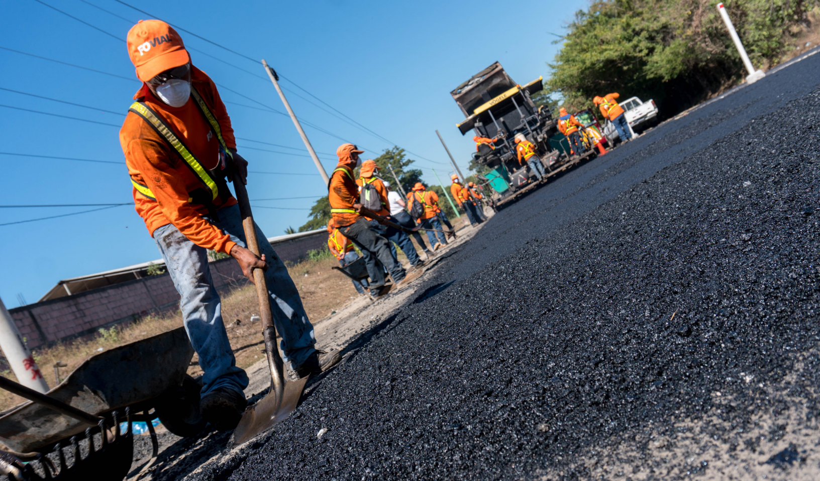
Colocación de mezcla asfáltica en mantenimiento periódico de carretera El Litoral, tramo: Kilo 5 - La Hachadura
