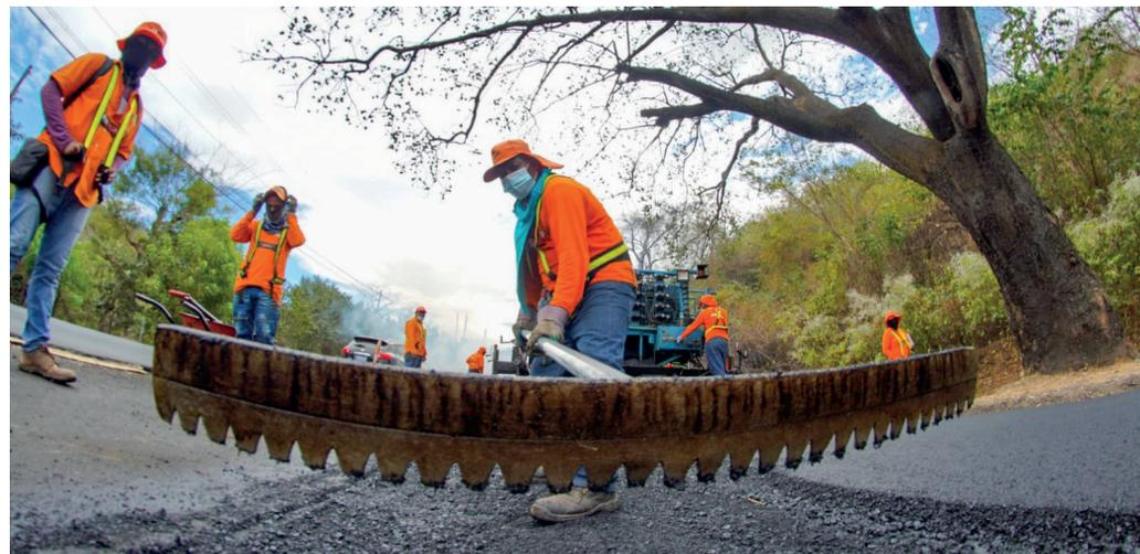
en caliente in-situ de mezcla asfáltica existente, colocación de carpeta asfáltica en caliente con asfalto modificado, construcción de drenajes laterales y señalización horizontal y vertical.
