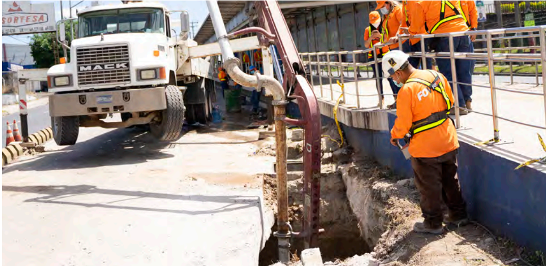
Relleno de lodocreto en cárcava en bulevar del Ejército.
