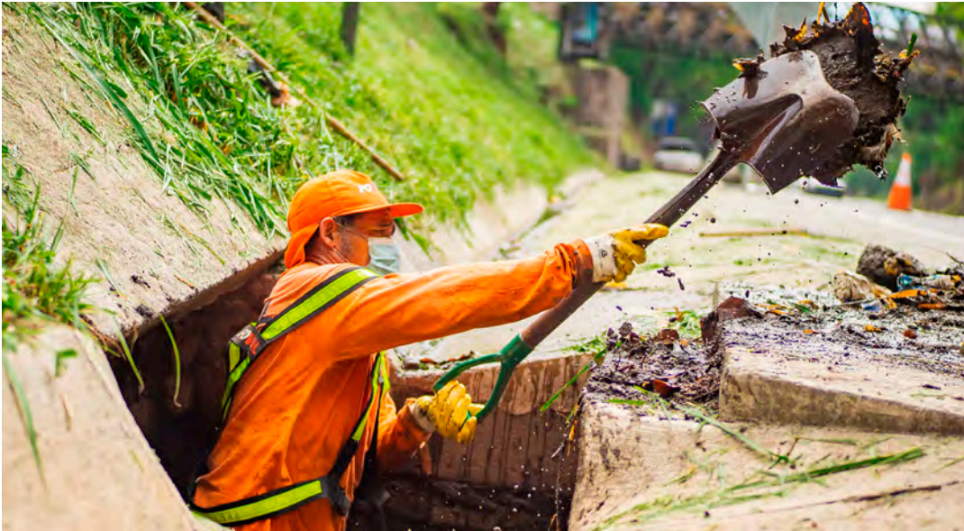
Limpieza de drenajes en carretera a Santa Tecla.
