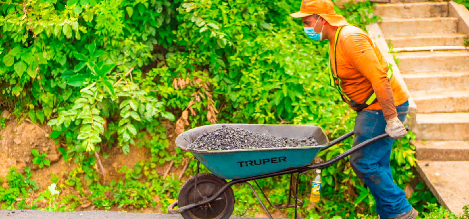
Trabajador transportando grava en proyecto de mantenimiento rutinario.
