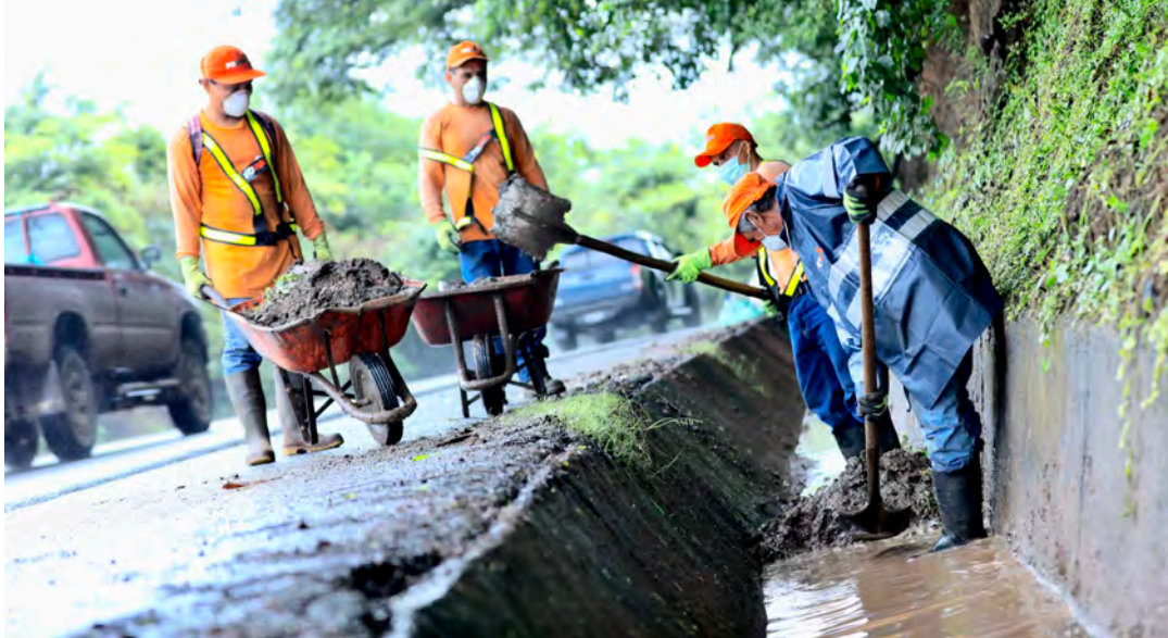
Limpieza de cunetas.
