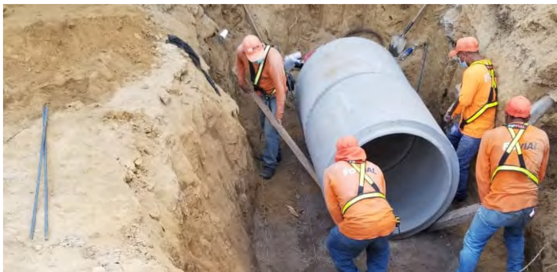
Instalación de tubería en carretera Metapán - Citalá
