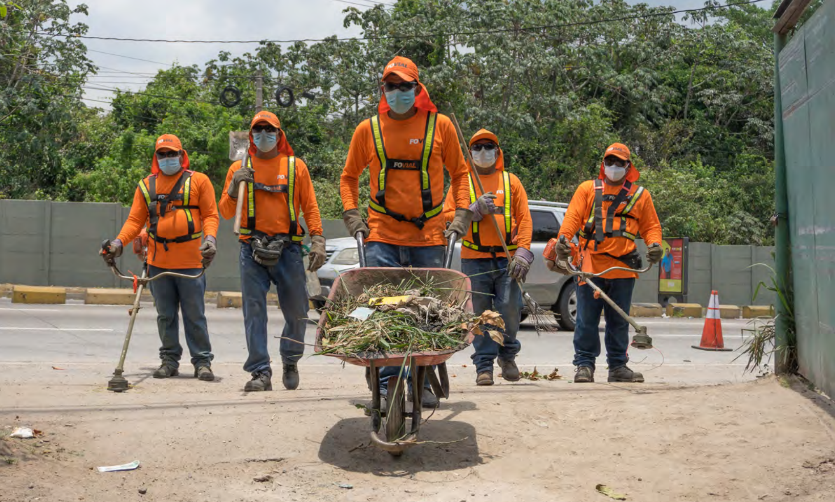
Cuadrilla de mantenimiento del derecho de vía.
