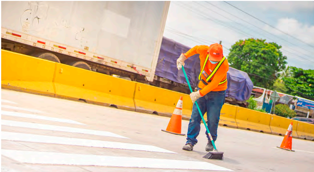
Limpieza de paso peatonal en carretera a Sonsonate.
