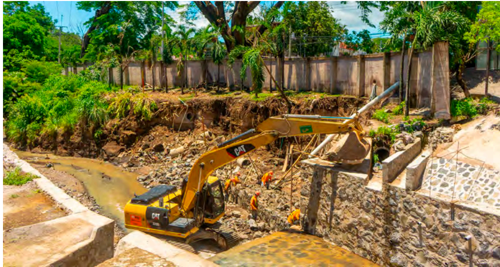
Construcción de muro de mampostería de piedra en El Molino, Santa Ana.
