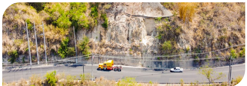
Estabilización de talud en calle Agua Caliente
