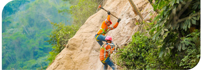
Obra de mitigación: estabilización de taludes en carretera Los Chorros
