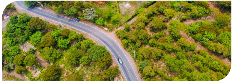
Recarpeteo carretera al Cerro Verde
