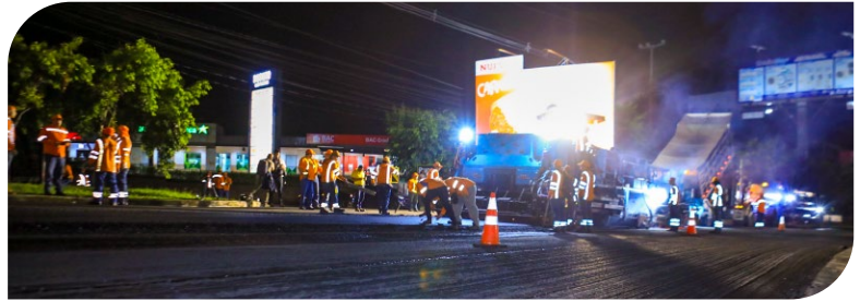
FOVIAL renueva un tramo de la carretera al puerto de La Libertad
