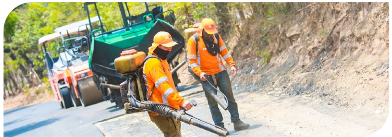
Continúan trabajos de pavimentación en cantón Tierra Blanca, San Miguel
