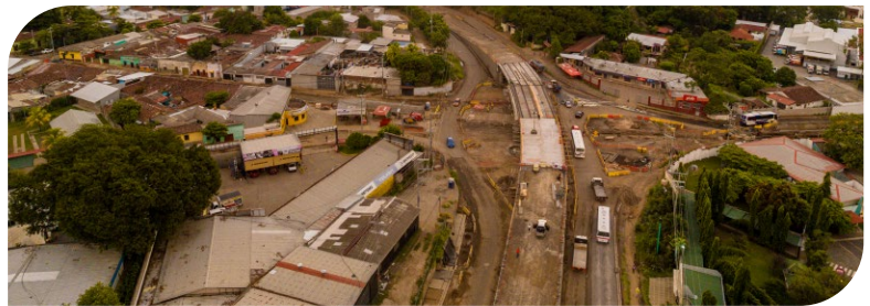
Autoridades de FOVIAL supervisan ejecución de paso a desnivel en redondeo UNICAES, Santa Ana
