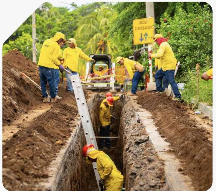
El proyecto se desarrollará en dos etapas. La primera etapa consiste en el diseño, que incluye demoliciones y rellenos, la construcción de ductos y pozos, y la canalización telefónica y eléctrica. La segunda etapa corresponde a la construcción, la cual abarca trabajos de terracería, trazado y excavaciones, rellenos con suelo-cemento, la instalación de acero de refuerzo y concreto, y la construcción de banco de ductos y obra metálica.
