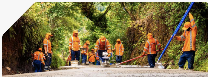
FOVIAL construye pavimento de concreto ruta: Ilobasco - San José Calera, Cabañas Pág.13
