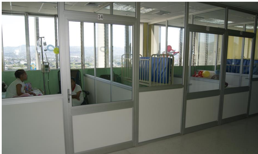
Remodelación del Servicio de Oncología
