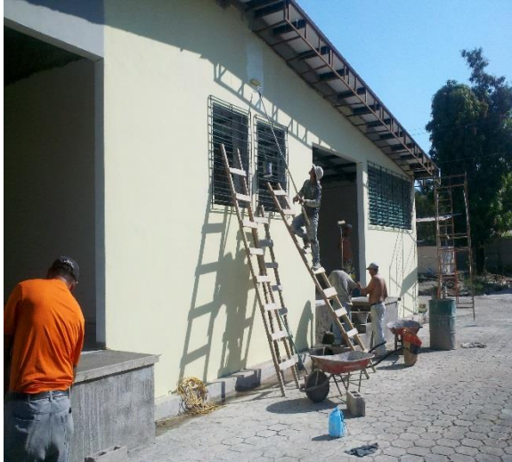
Construcción del Almacén
