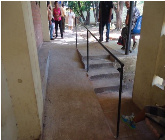
Construcción de Rampla de Fisioterapia
