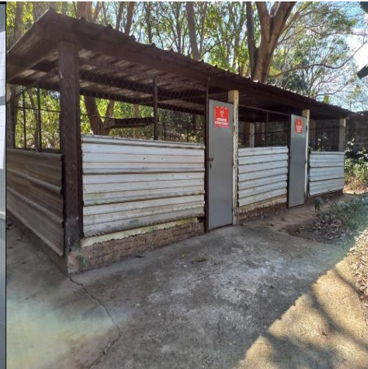
Celda de seguridad.
