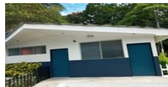
Reparación de techo de Clínica Atención Integral
