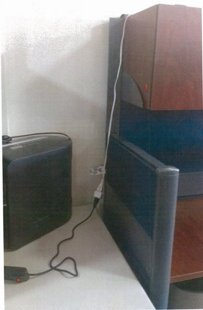
Imagen 19 de 19: Conexión eléctrica improvisada en al UGDA.
