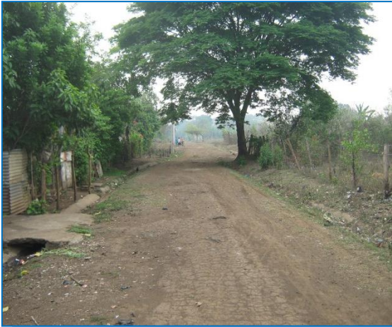
Inspección técnica para estudio hidrológico, verificación de canaletas en comunidad Paraíso Escondido.
