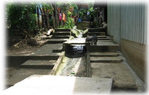
Inspección de campo para diseño de obras hidráulicas en comunidad Las Delicias.
