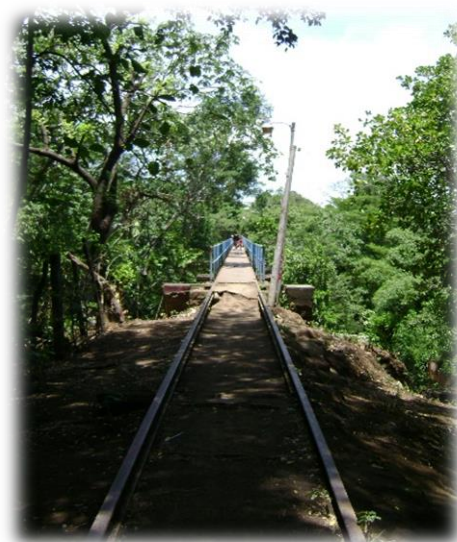
Inspección línea férrea Villa Cutuco Km 1.La Unión.
